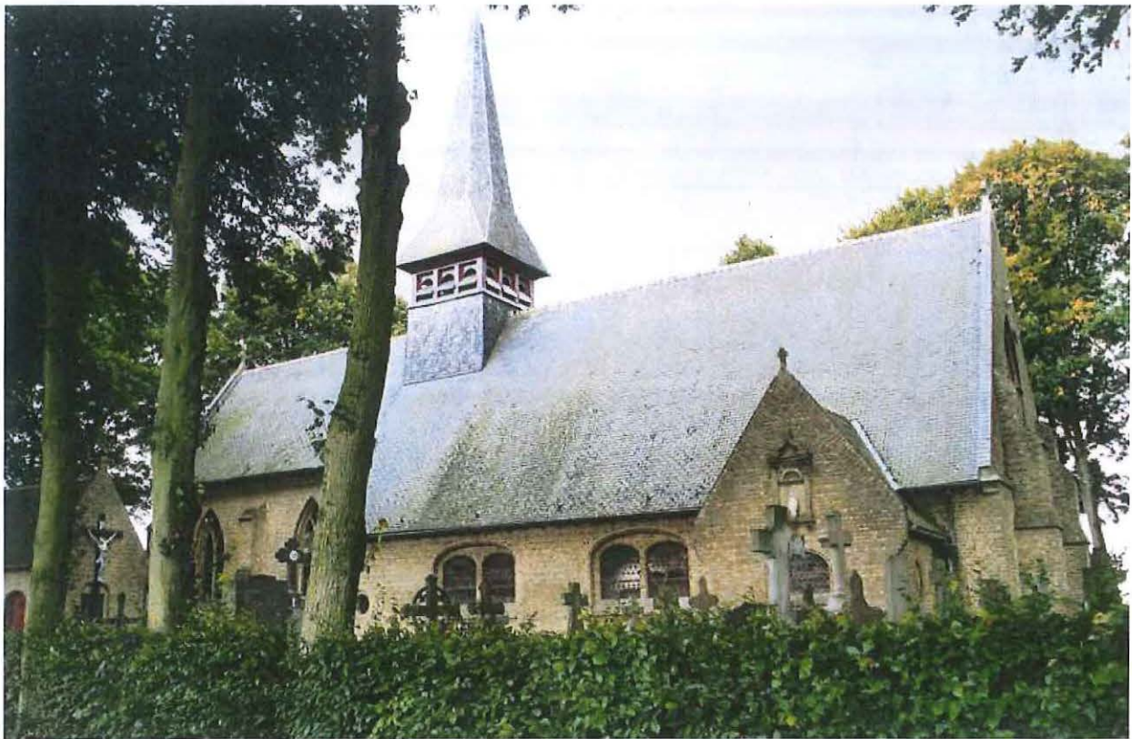
Noordgevel met doopkapel en sacristie
