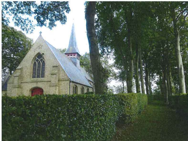
Westgevel en volumewerking van de kerk. De kerk en het kerkhof zijn omringd door een dubbele rij bomen en hagen (foto Koen Himpe, 2014)
