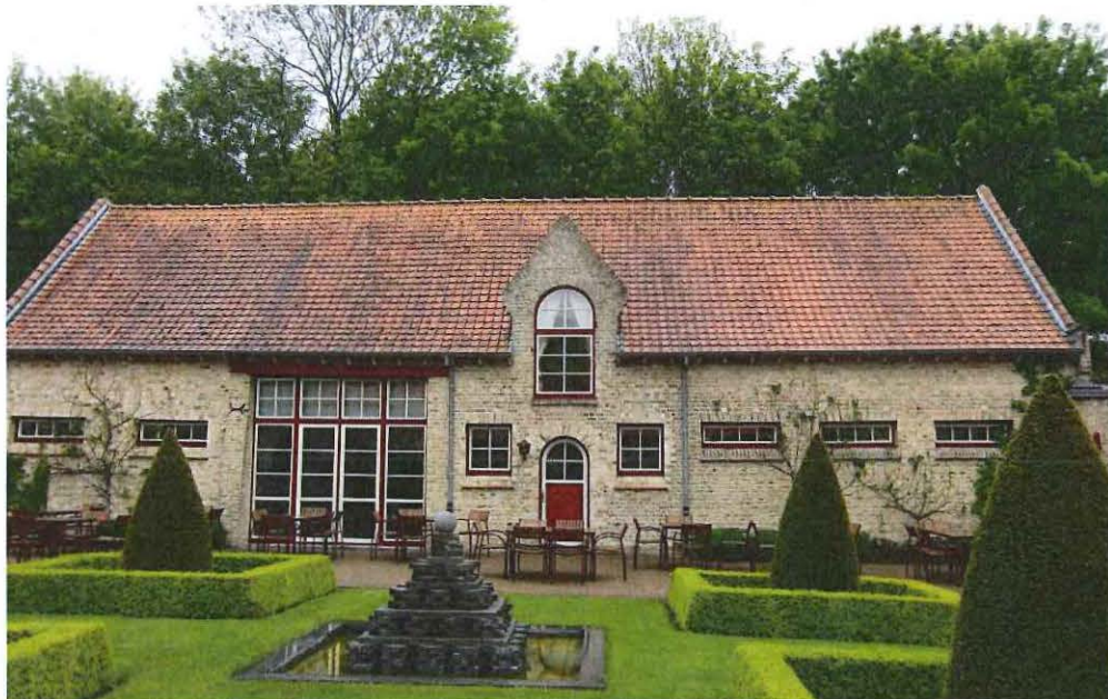
De gerenoveerde koeien- en paardenstalling
