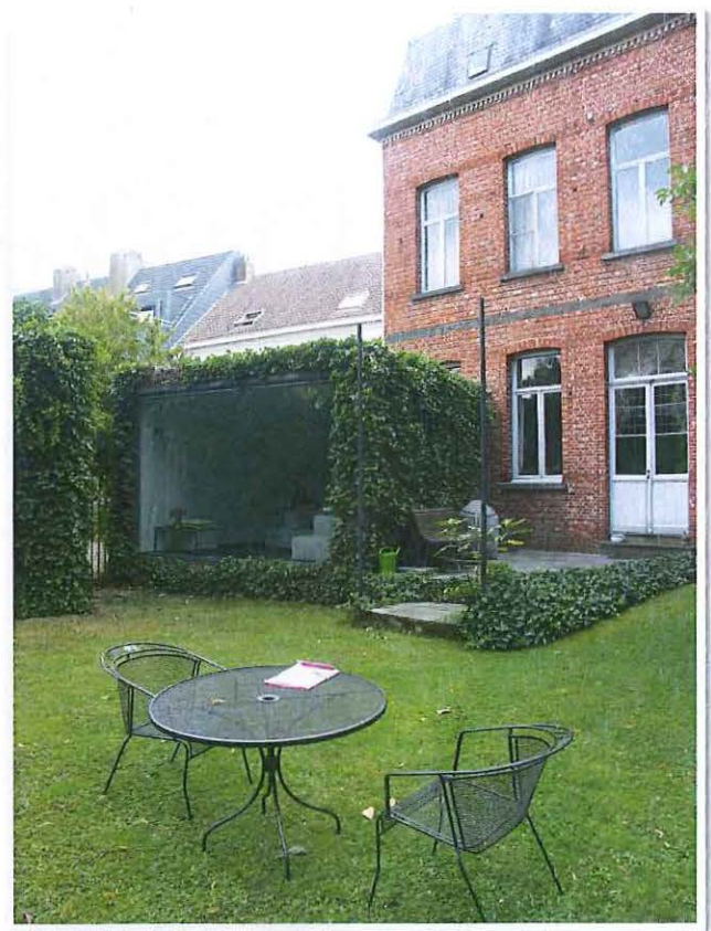
Foto 14: Achtergevel met aanbouw
