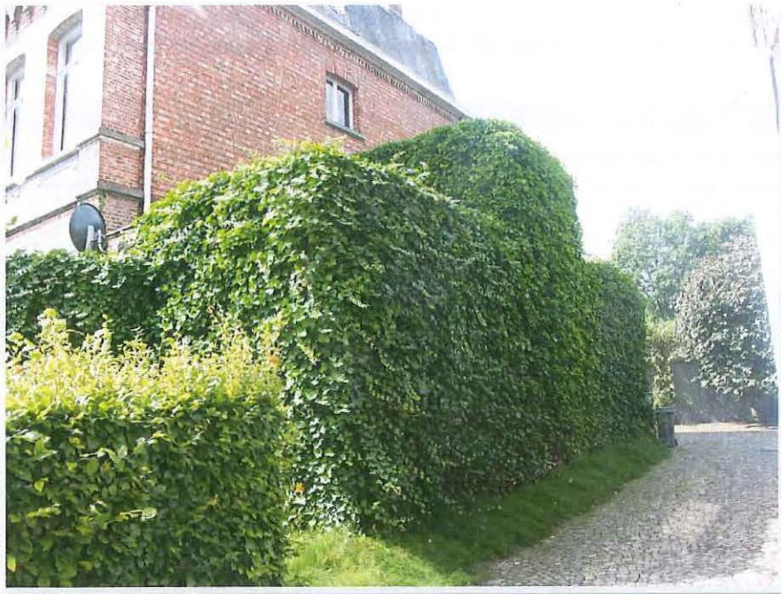
Foto 12: Rechterzijgevel met begroeide aanbouw
