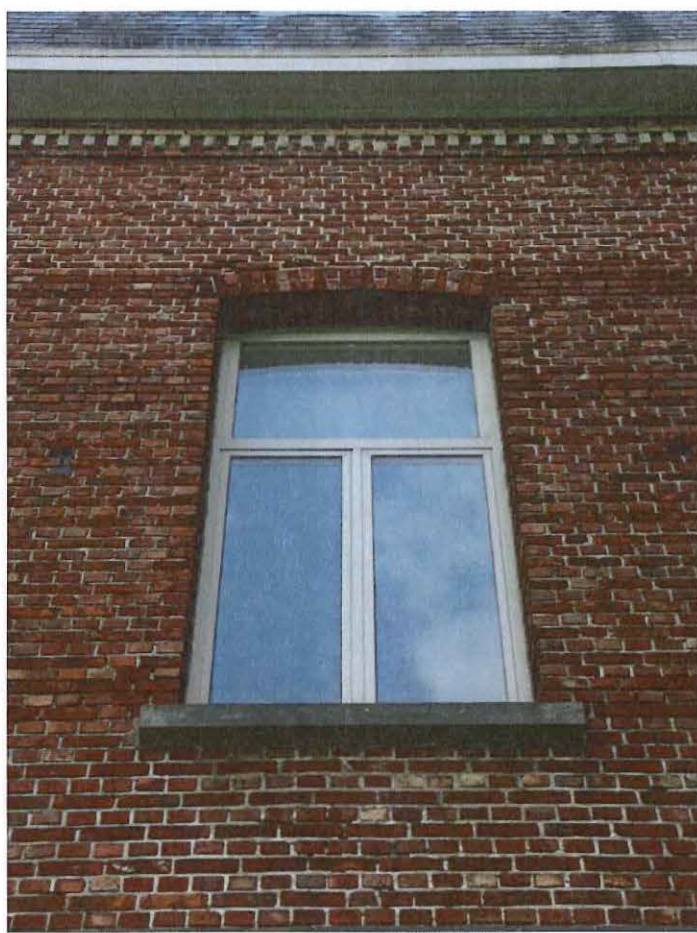
Foto 16: Achtergevel: bovenverdieping met aangepast schrijnwerk
