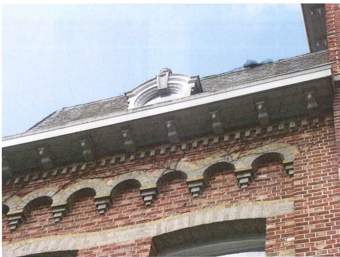
Foto 7: Voorgevel: gevelbeëindiging met baksteenfriezen-kroonlijst op modillons-oeil-de-boeuf
