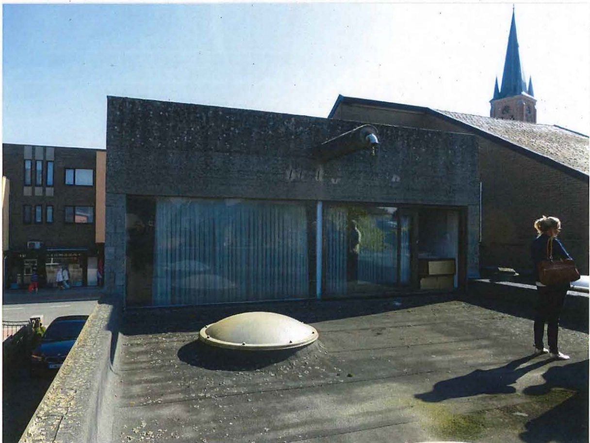
Foto 20: Achtergevel hoofdgebouw, eerste verdieping. Zicht genomen vanop het platte dak.
