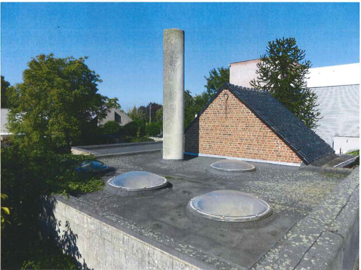
Foto 34: Garage. Zicht op het dak bestaande uit één koepel en achterliggende schouw van de verwarmingsketel. De koepels links zijn drie van de vijf koepels die het hoofdgebouw verlichten.
