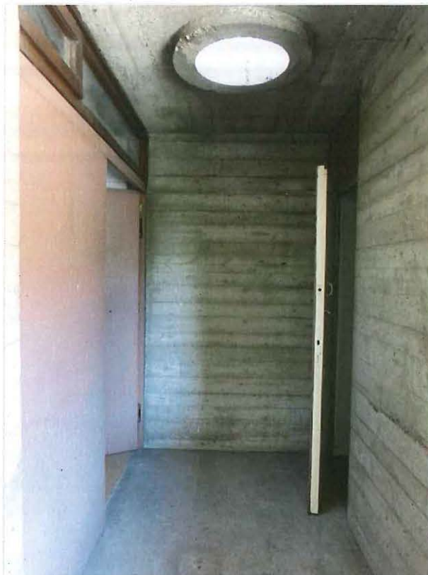
Foto 11: Voorgevel hoofdgebouw. Tweede bordes van de buitentrap met links de toegang tot de jeugdclub en rechts een toilet. Het bordes wordt centraal belicht door een cirkelvormige opening met koepel.
