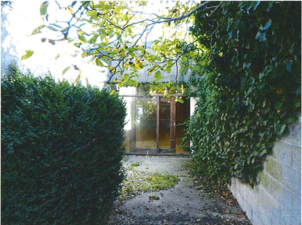
Foto 17: Achtergevel hoofdgebouw, gelijkvloers. Zicht vanuit de binnentuin.
