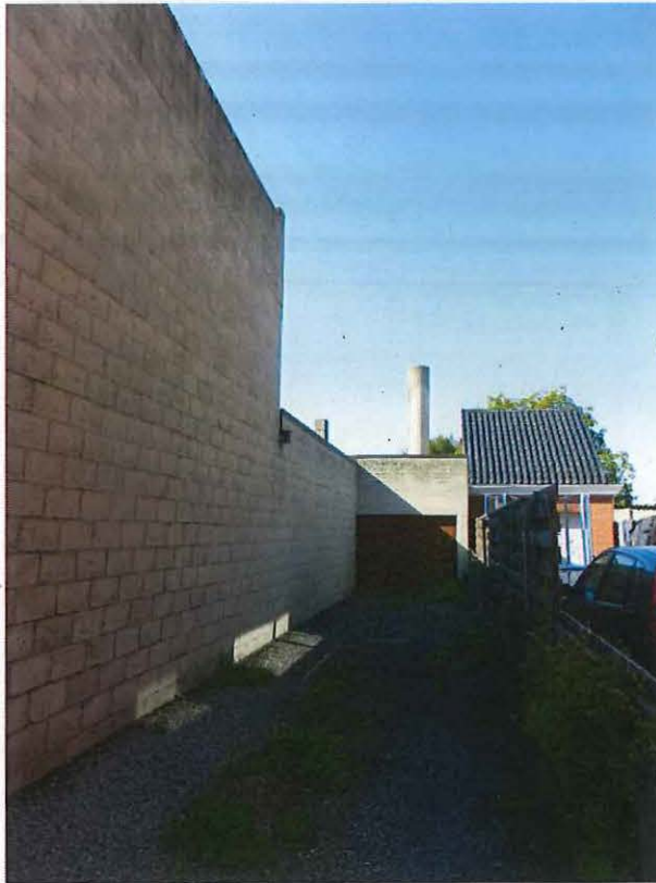
Foto 31: Oprit met achterliggende garage.
