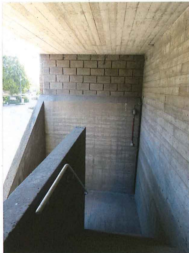
Foto 8: Voorgevel hoofdgebouw. Het gesloten zicht ter hoogte van het eerste bordes van de buitentrap.
