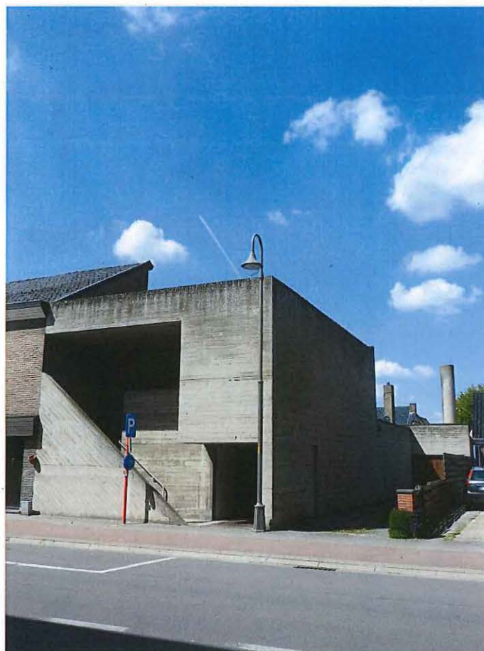
Foto 4: Voor- en zijgevel van de voormalige bibliotheek, met rechts de oprit naar de achterliggende garage.
