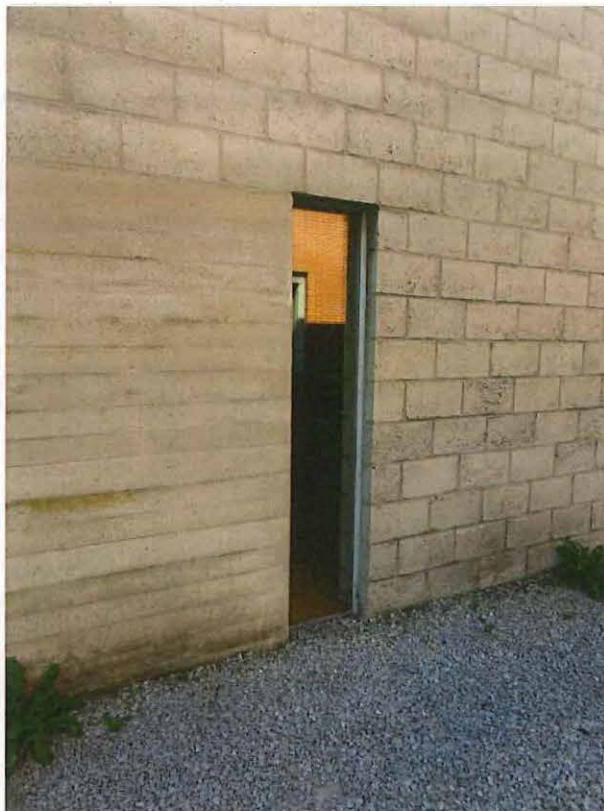
Foto 15: Rechter zijgevel hoofdgebouw. Detail van de smalle vensteropening.
