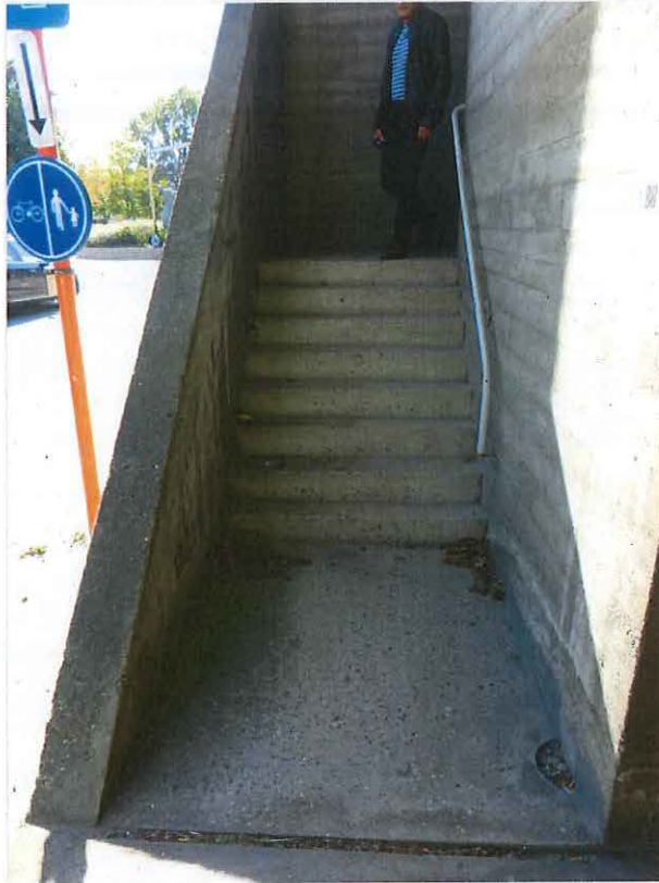
Foto 7: Voorgevel hoofdgebouw. Buitentrap naar het eerste bordes.
