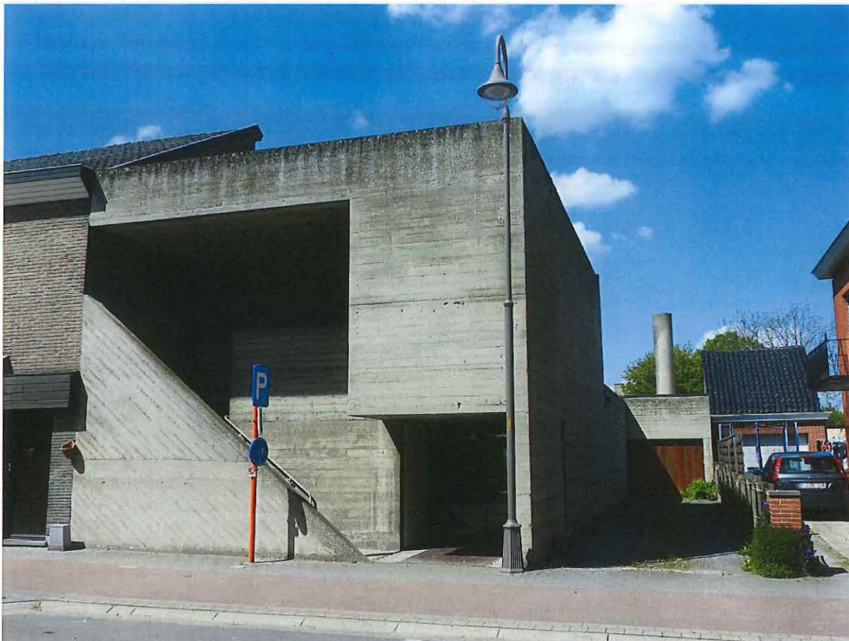
Foto 3: Voorgevel van de voormalige bibliotheek, met rechts de oprit naar de achterliggende garage.
