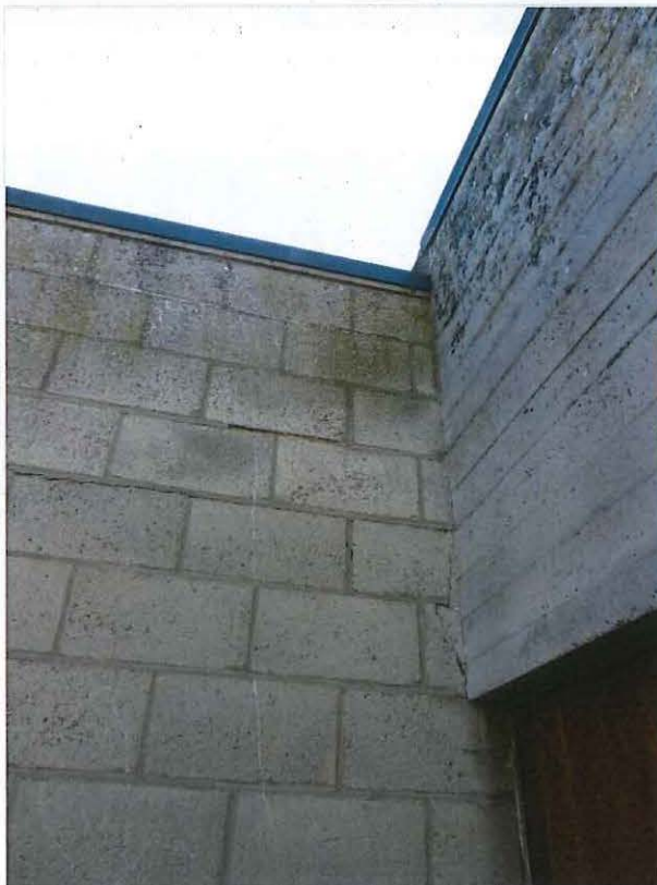
Foto 32: Overgang tussen de rechterzijmuur van het hoofdbouw en de garage.
