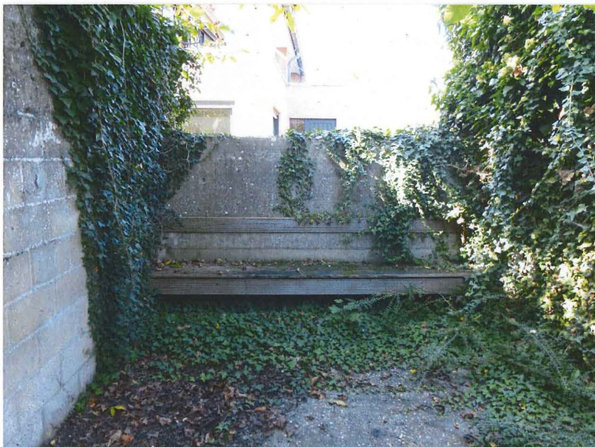
Foto 30: Binnentuin. Zicht op de achtergevel van de binnentuin die samen met de zitbank in één stuk werd gegoten.
