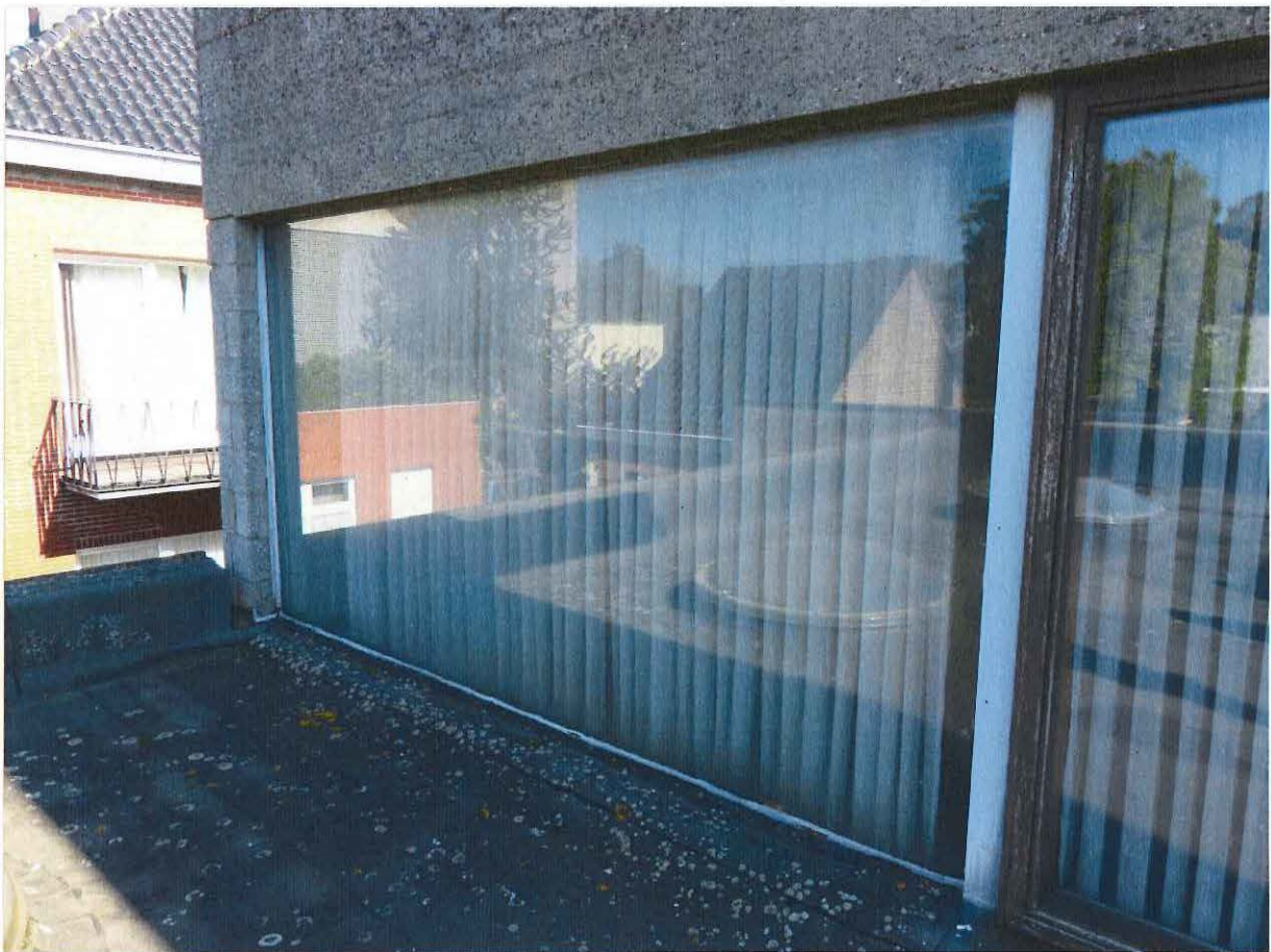
Foto 25: Achtergevel hoofgebouw, eerste verdieping. Detail vensteropening met vast raam.
