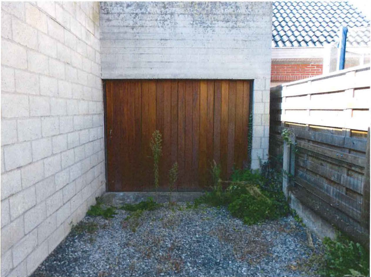
Foto 33: Garage met houten, vierdelige garagepoort.
