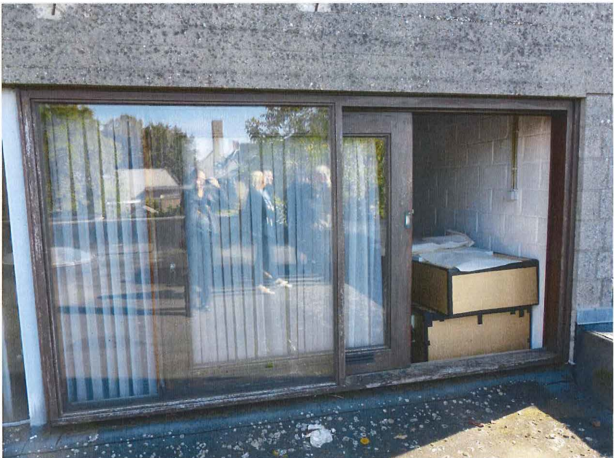
Foto 26: Achtergevel hoofgebouw, eerste verdieping. Detail vensteropening met schuifraam.
