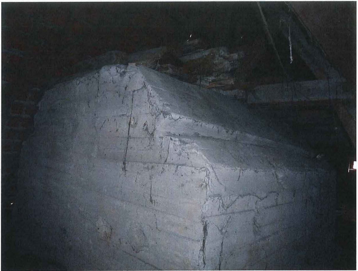
Foto 3: Een uitsparing van een gording in de betonnen dakrand.
