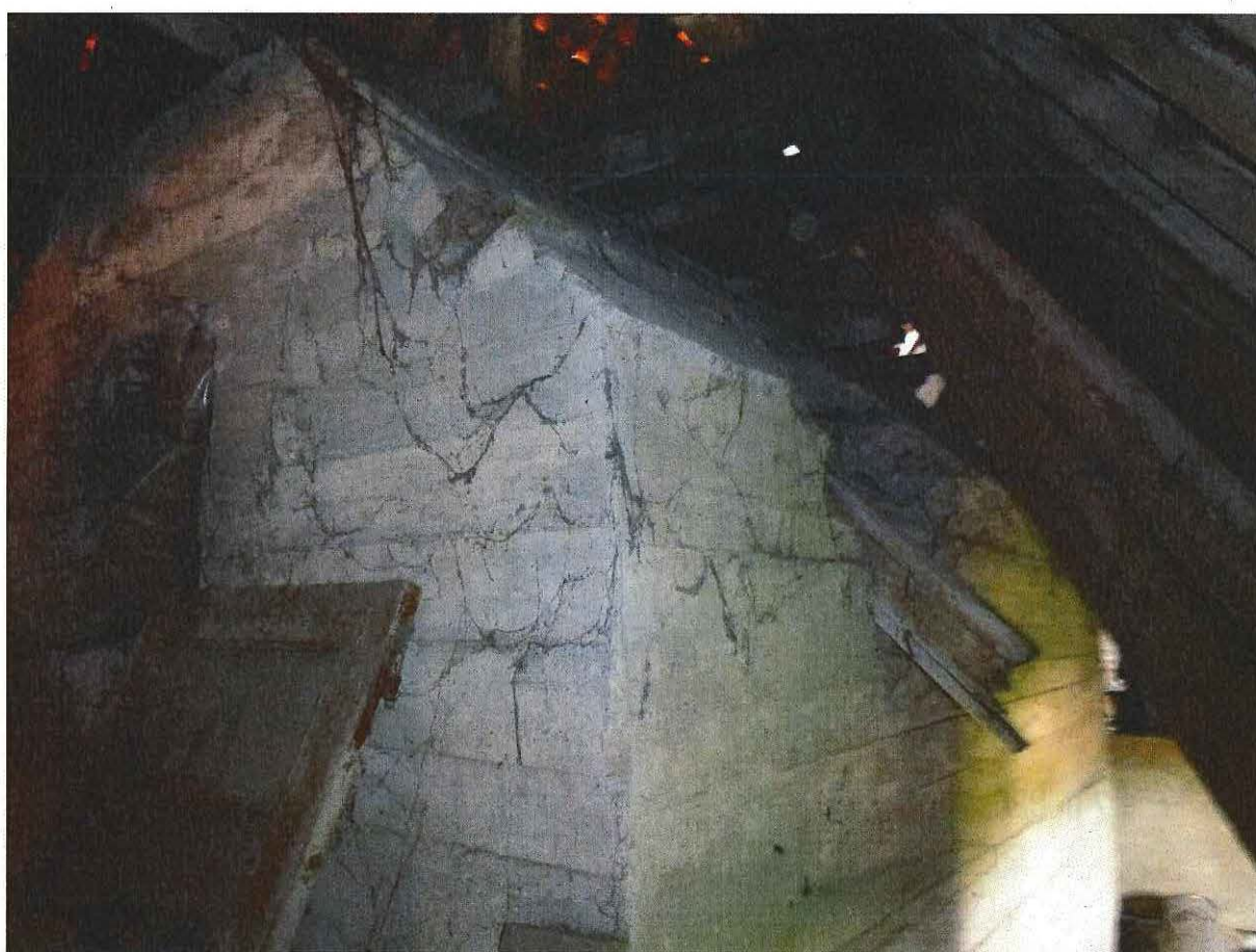
Foto 2: De bewaarde keper van het vooroorlogse dak aan noordwestelijke zijde.
