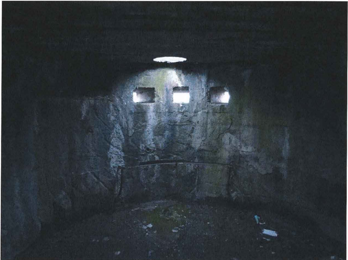
Foto 9: Binnenzicht in de betonnen post.
