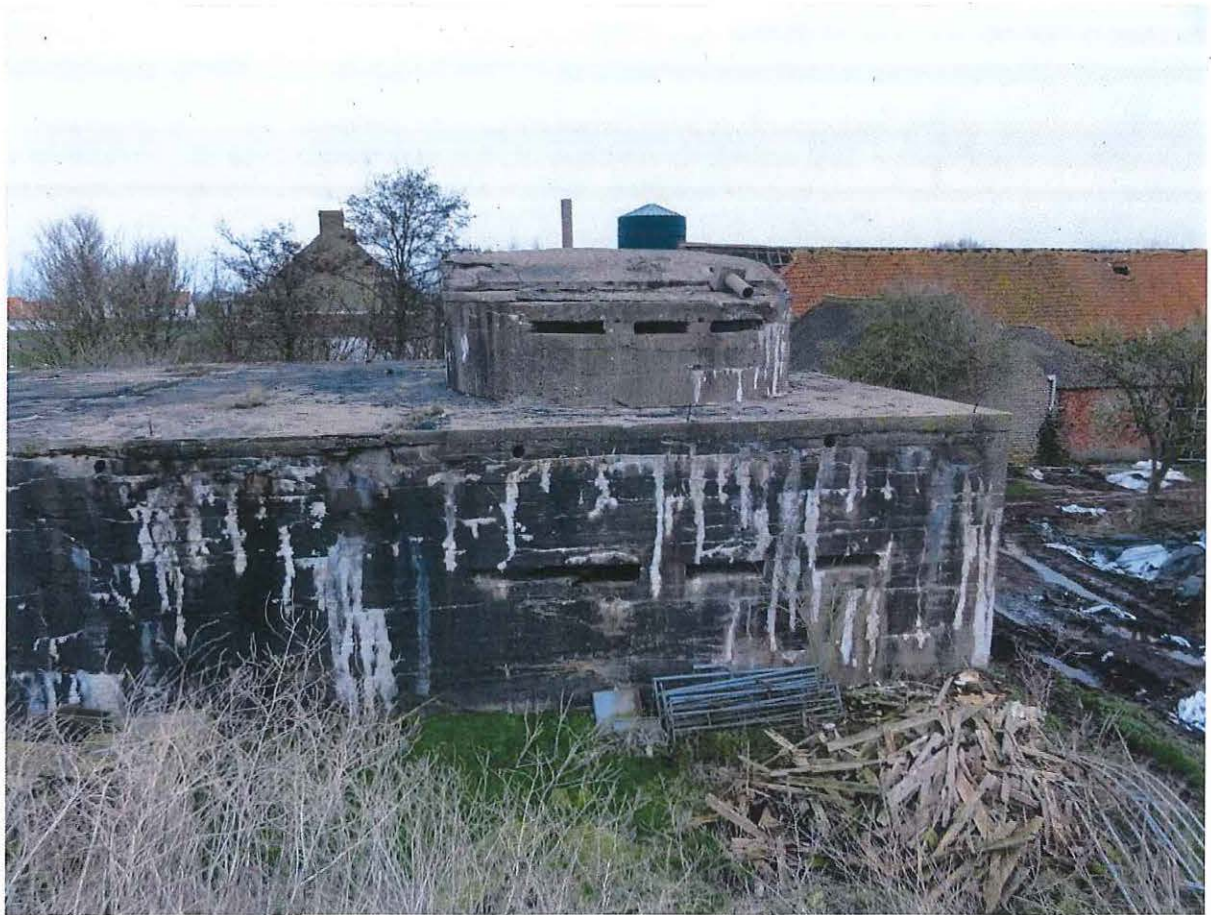
Foto 3: Zicht op de bunker.
