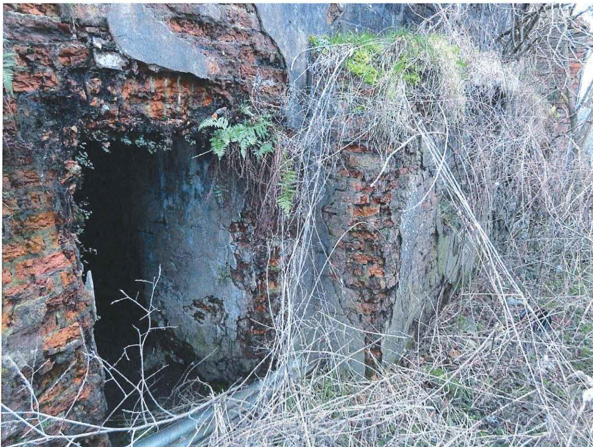
Foto 5: Detail van het metselherstelwerk aan de achterzijde van de bunker.
