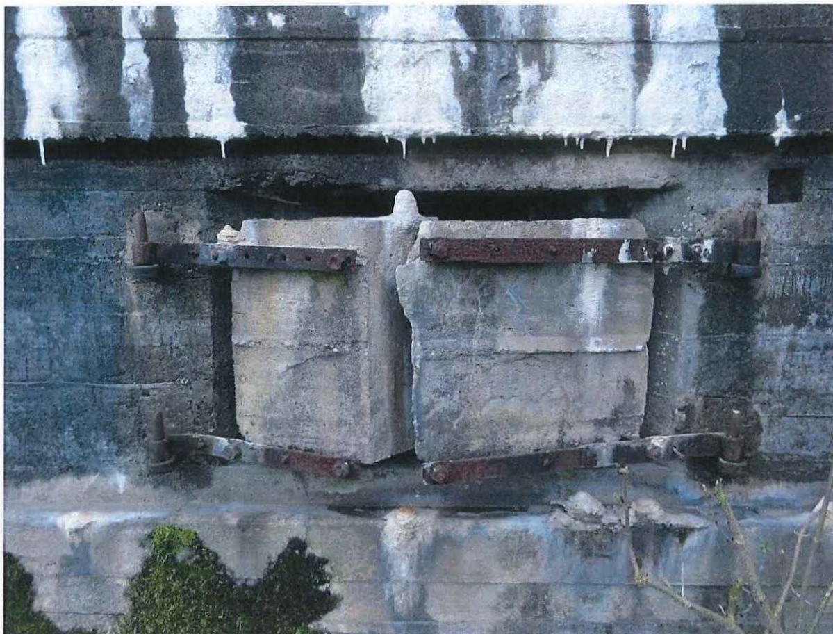
Foto 7: Betonnen luiken aan de noordoostelijke zijkant.
