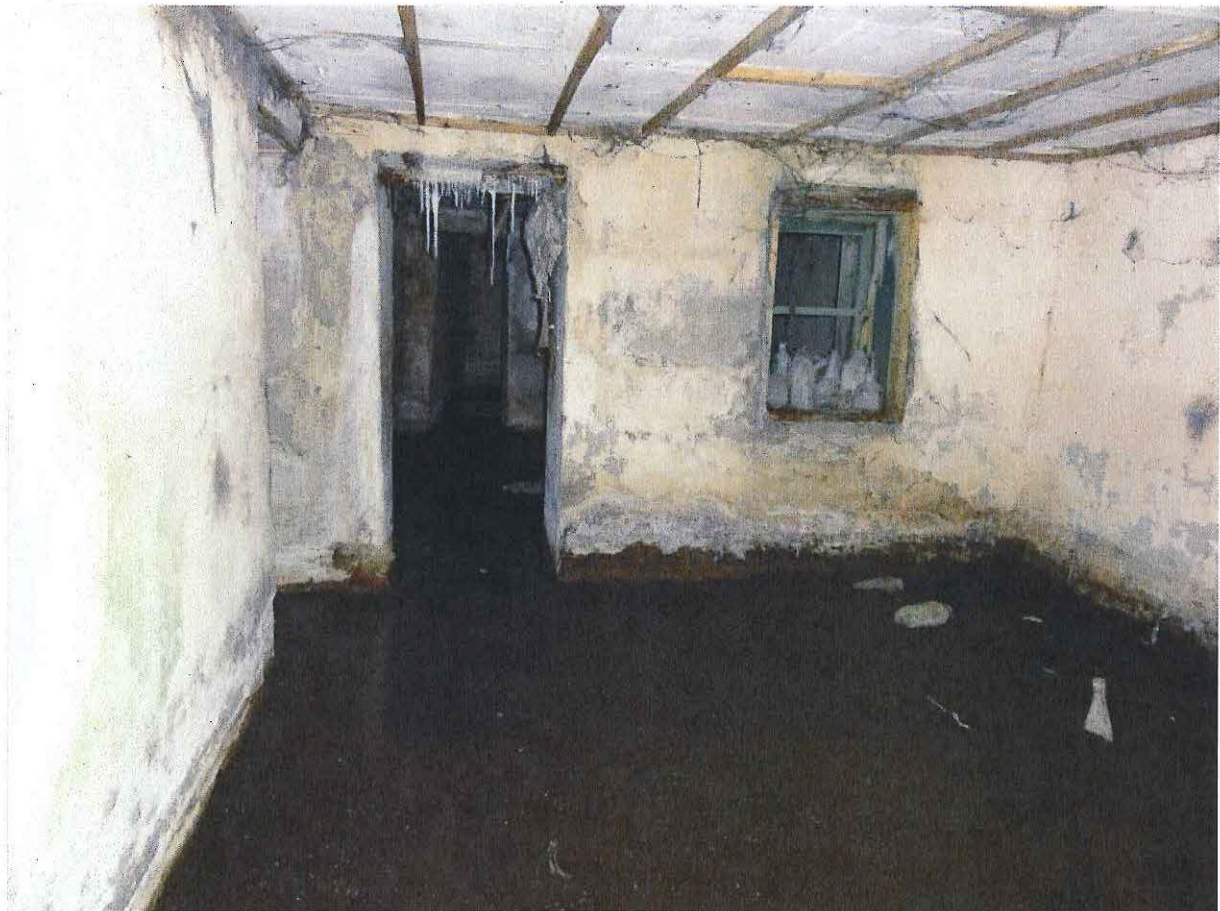
Foto 10: Zicht in de bunker.
