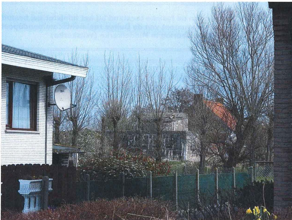
Foto 1: Ligging bunker, vanaf de Spermaliestraat.
