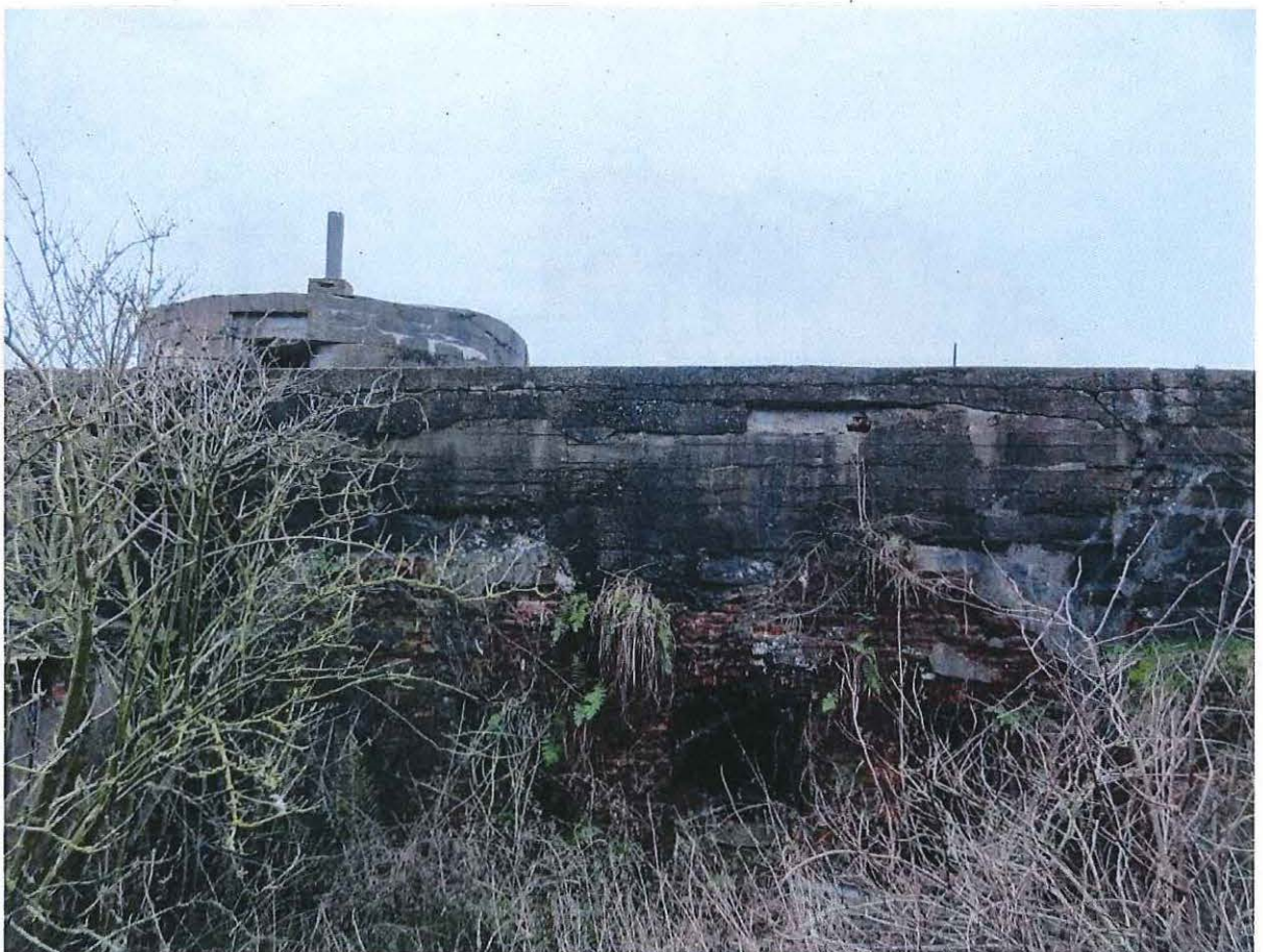
Foto 4: De achterzijde (noordoostelijke zijde) met metselherstelwerk uit de Tweede Wereldoorlog.
