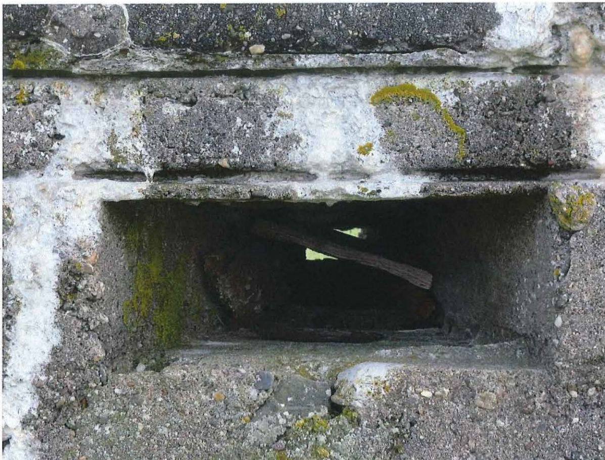
Foto 7: Schietopening aan de buitenzijde
