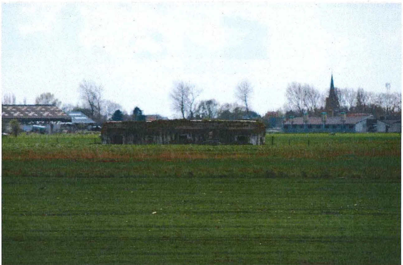
Foto 2: Ligging van de bunker met zicht op de achterzijde
