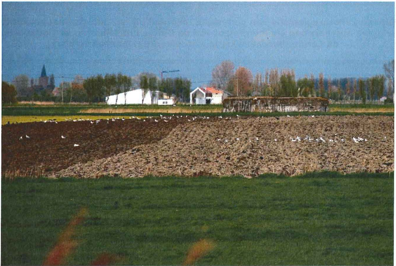
Foto 1: Ligging van de bunker met zicht op de frontzijde
