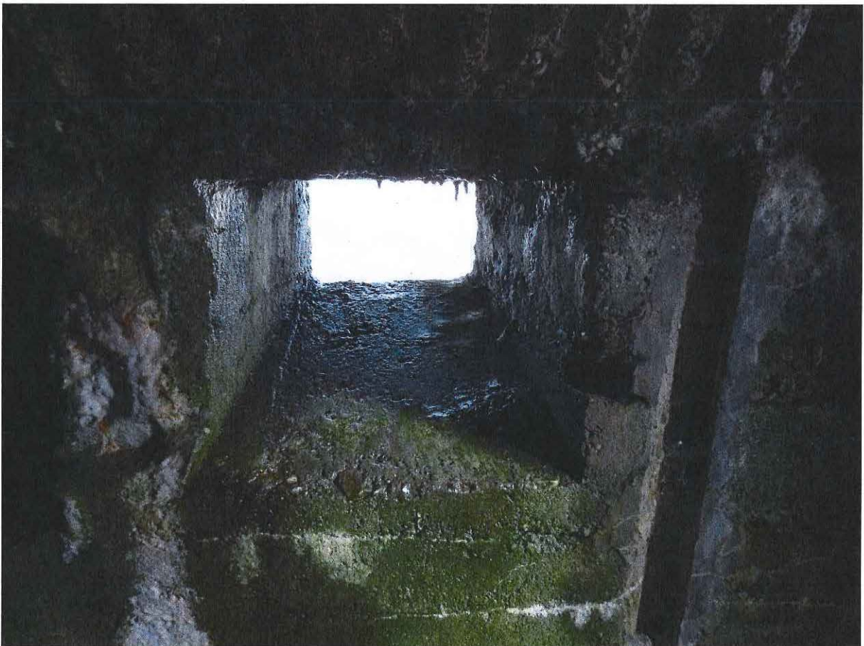
Foto 6: Een vensteropening vanaf de binnenzijde van de bunker
