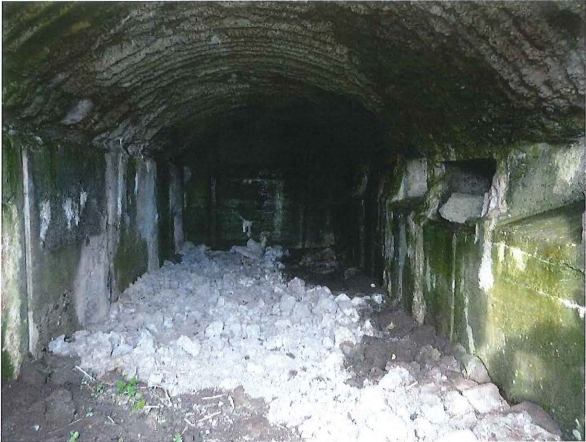
Foto 7: Zicht op de binnenzijde van de bunker
