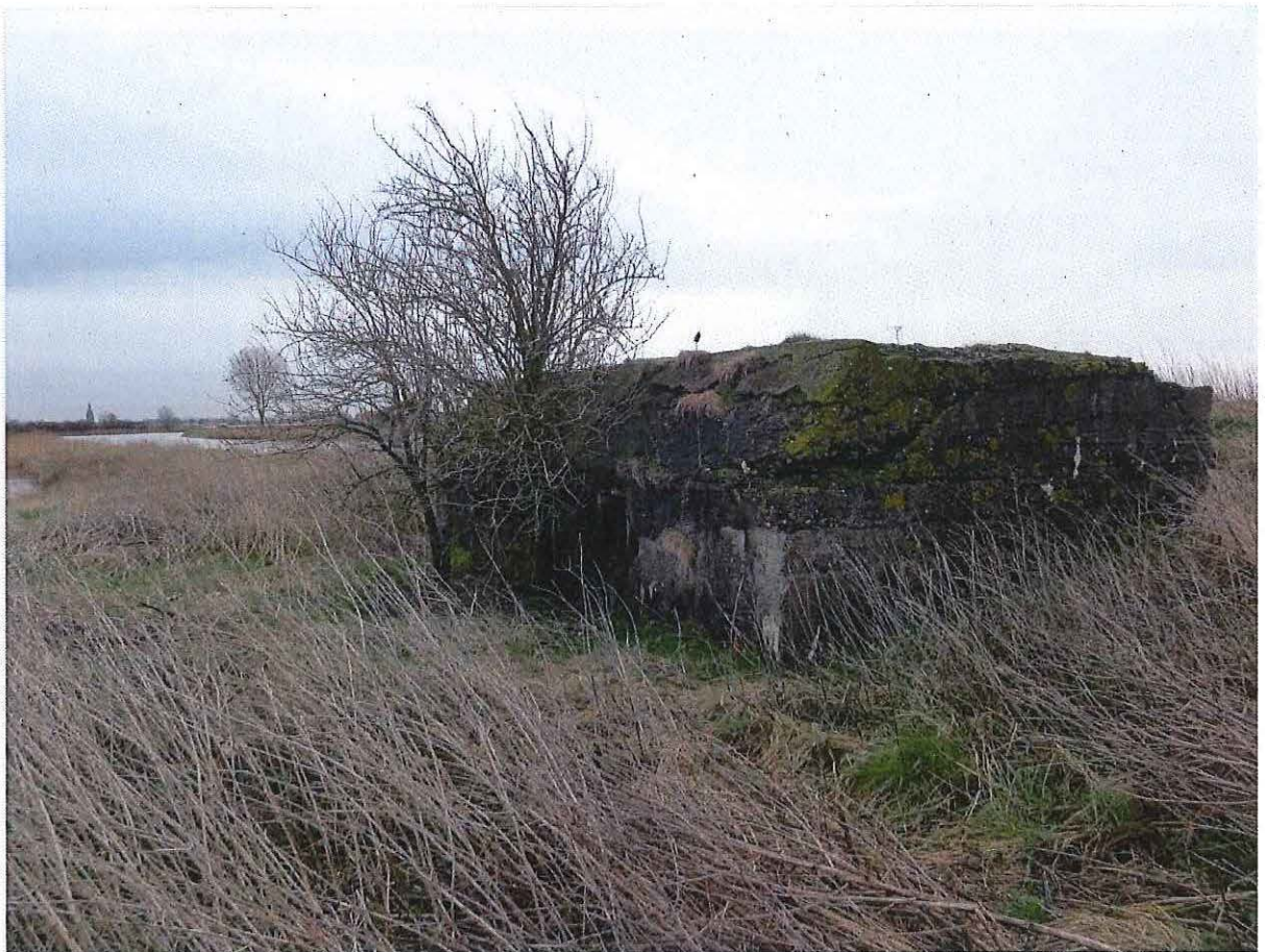
Foto 4: Zicht op de noordoostelijke muur
