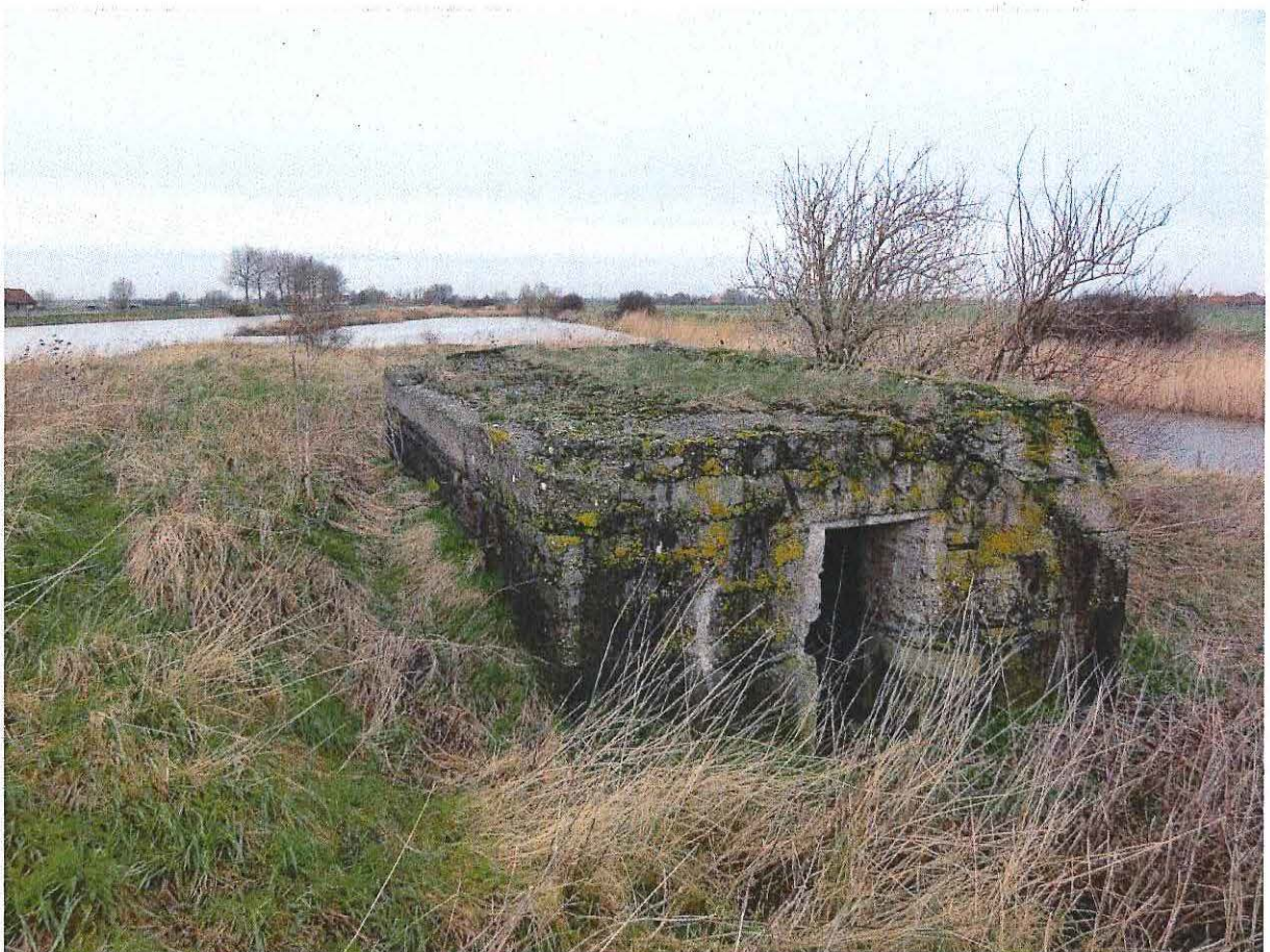
Foto 2: Zicht op de toegang van de bunker aan zuidoostelijke zijde
