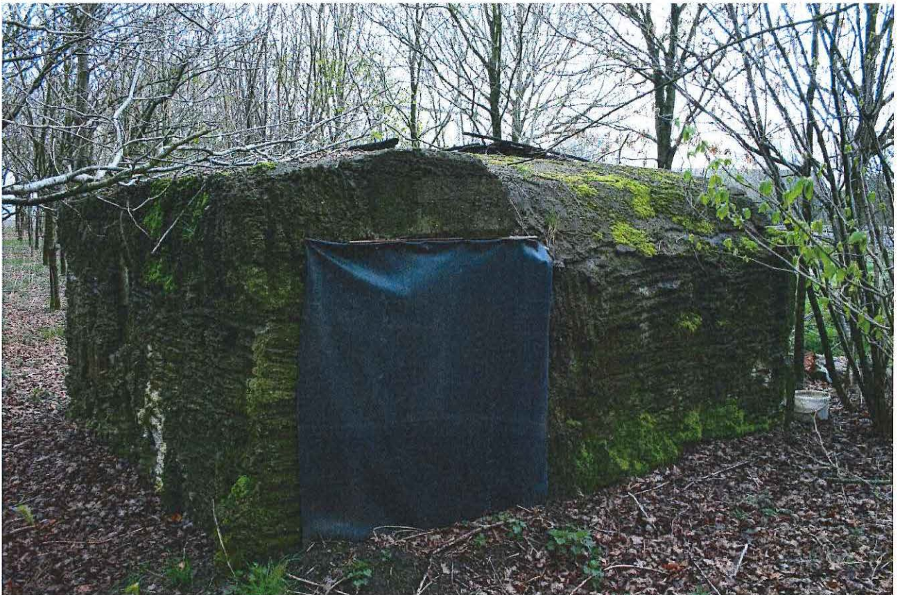
Foto 2: De westelijke zijde van de bunker.
