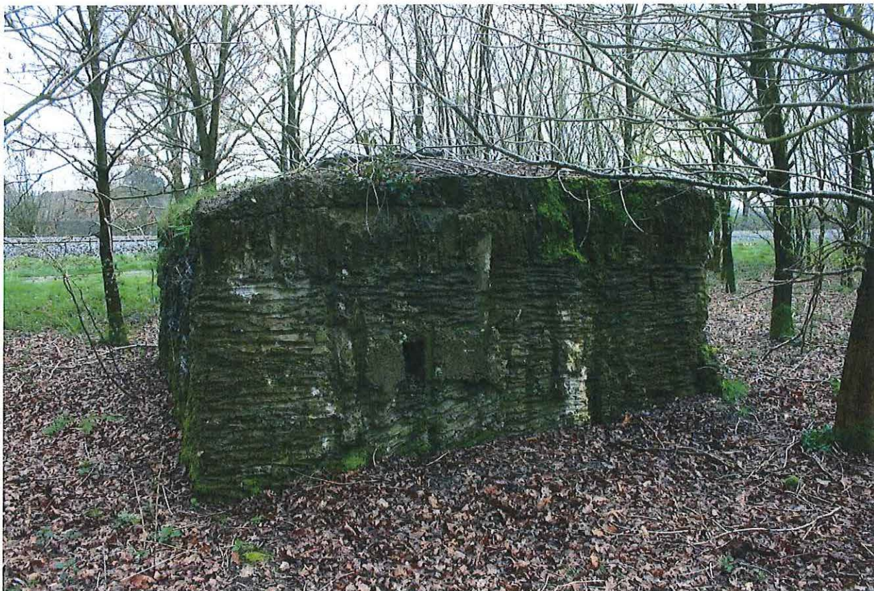
Foto 3: De noordelijke zijde van de bunker.
