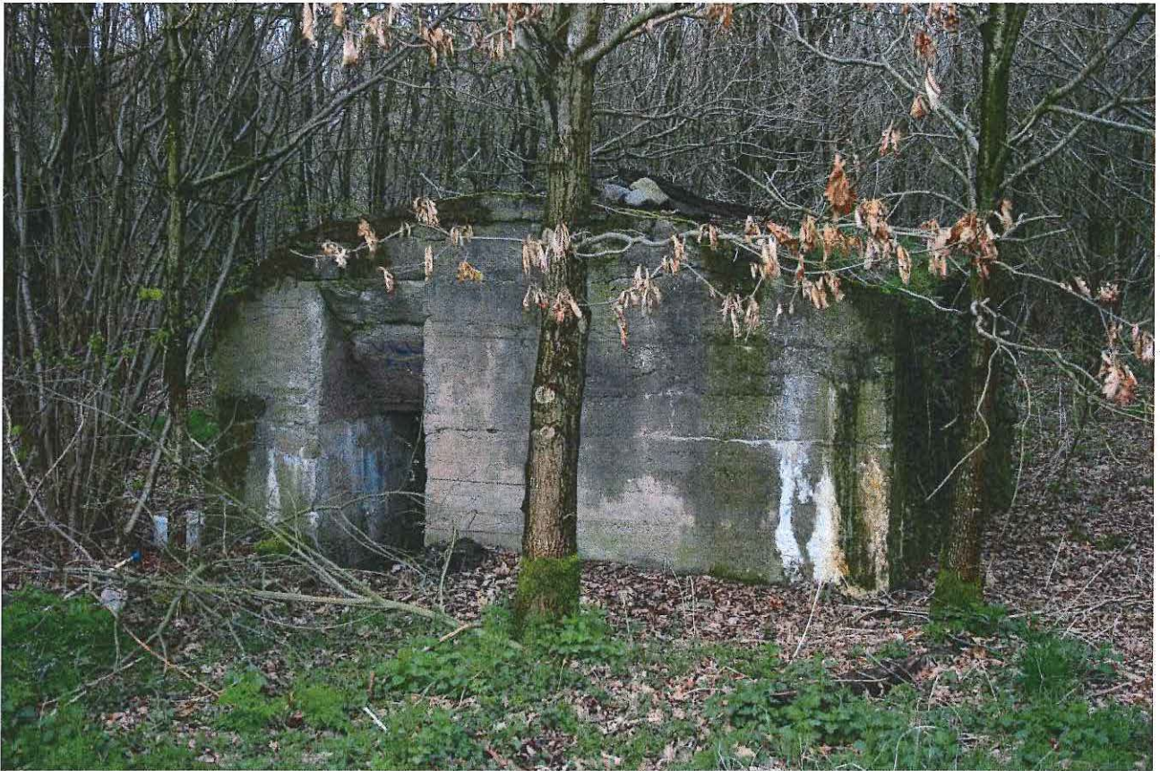
Foto 1: De zuidelijke zijde van de bunker.
