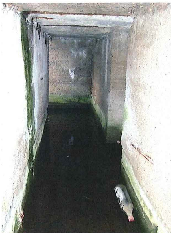
Foto 4: De gang van de bunker.
