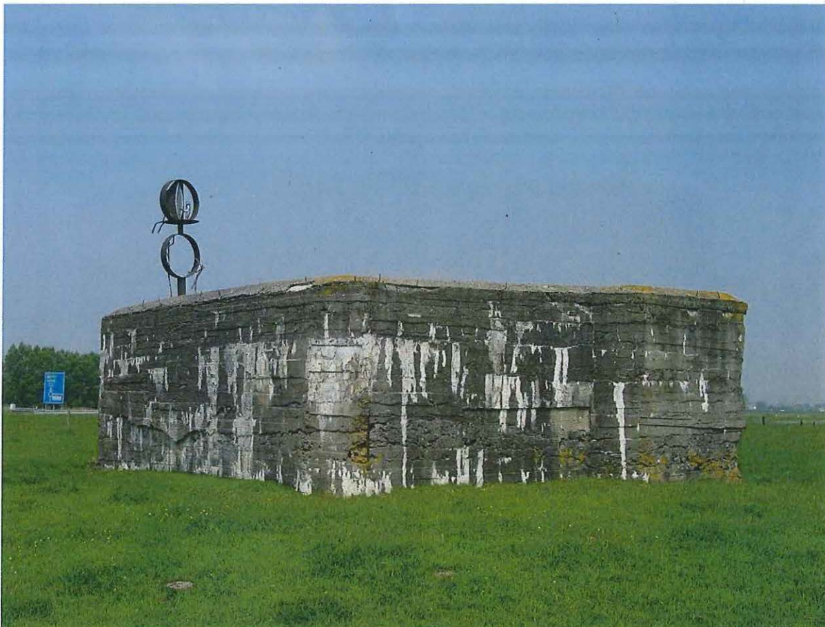
Foto 3: De zuidelijke en westelijke zijde van de meest noordelijke constructie. Tegen de dakrand zijn de ijzers voor de bevestiging van camouflagenetten te zien.
