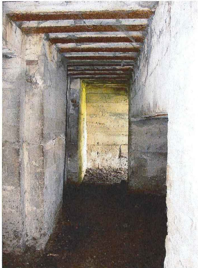
Foto 6: De gang met nis van de meest zuidelijke bunker
