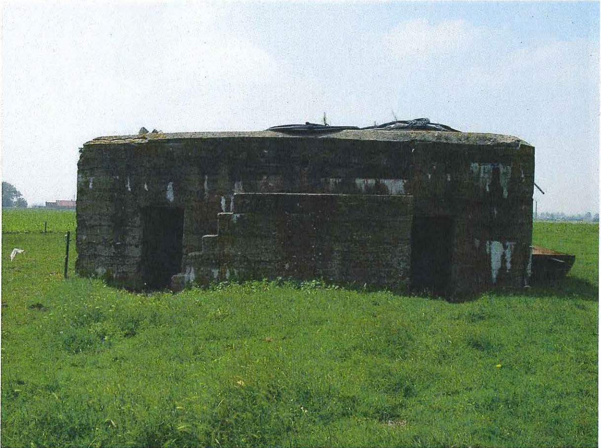
Foto 5: Toegangzijde van de meest zuidelijke bunker
