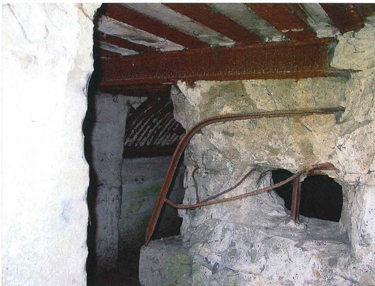
Foto 4: Zicht in de noordelijke bunker
