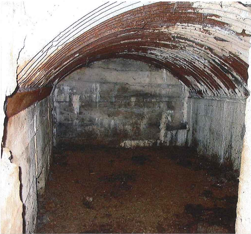
Foto 7: Een binnenruimte van de meest zuidelijke constructie, met zogenaamde Wellblechbogen (gebogen gegolfde plaatijzers) tegen het plafond.
