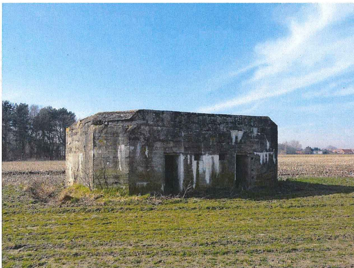
Foto 2: De toegangszijde (noordoostelijke zijde) van de bunker.
