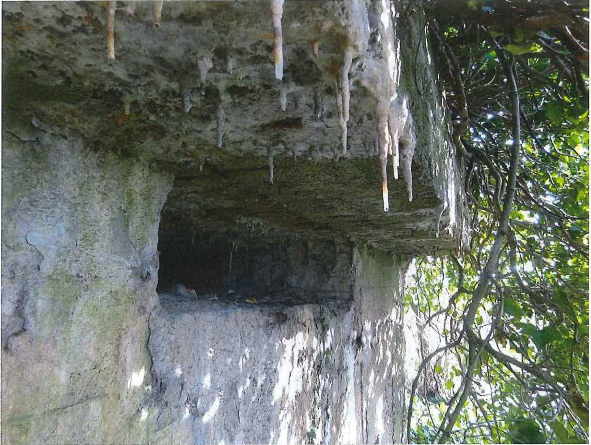
Foto 3: Een observatiegleuf onder de overkragende dakrand aan zuidwestelijke zijde.
