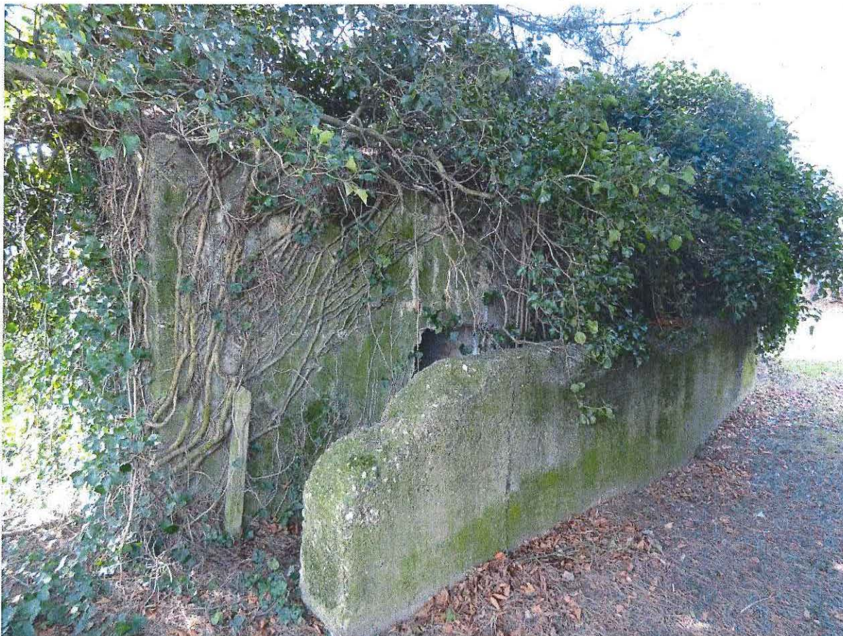
Foto 1: De achterzijde van de bunker, met bijkomend muurtje.
