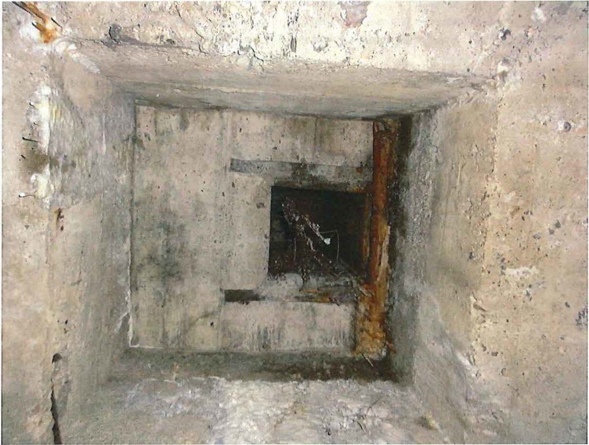
Foto 7: Een observatie-opening in het plafond.
