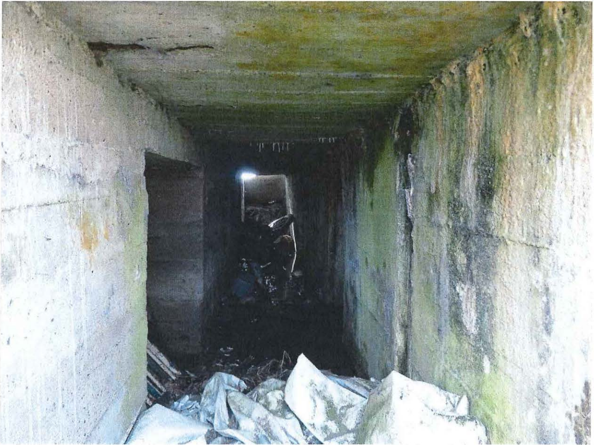
Foto 5: Zicht in de gang.
