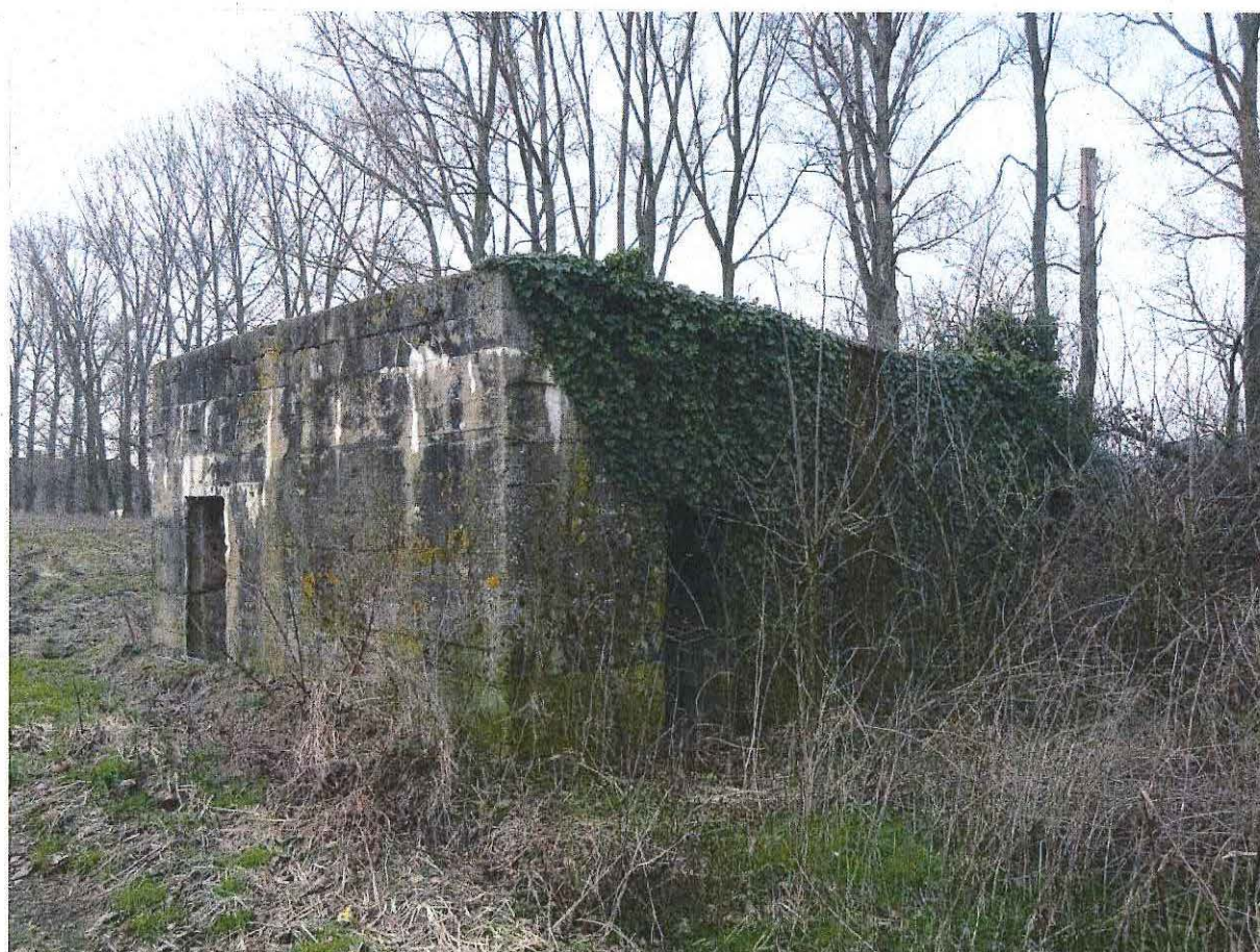
Foto 2: De twee toegangen van de bunker aan noordelijke en oostelijke zijde.
