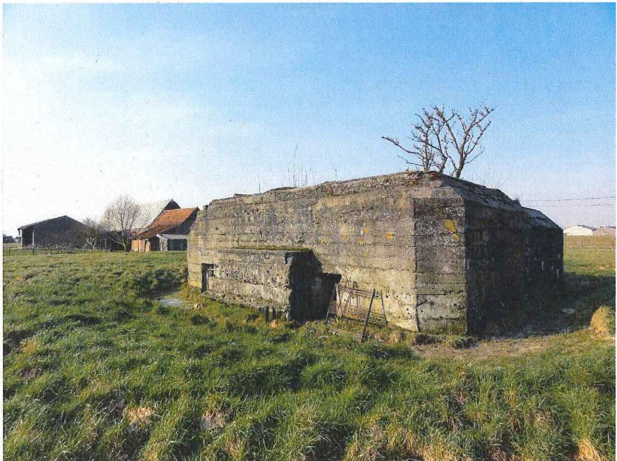
Foto 2: De oostelijke zijde van de bunker, met richel en trap.
