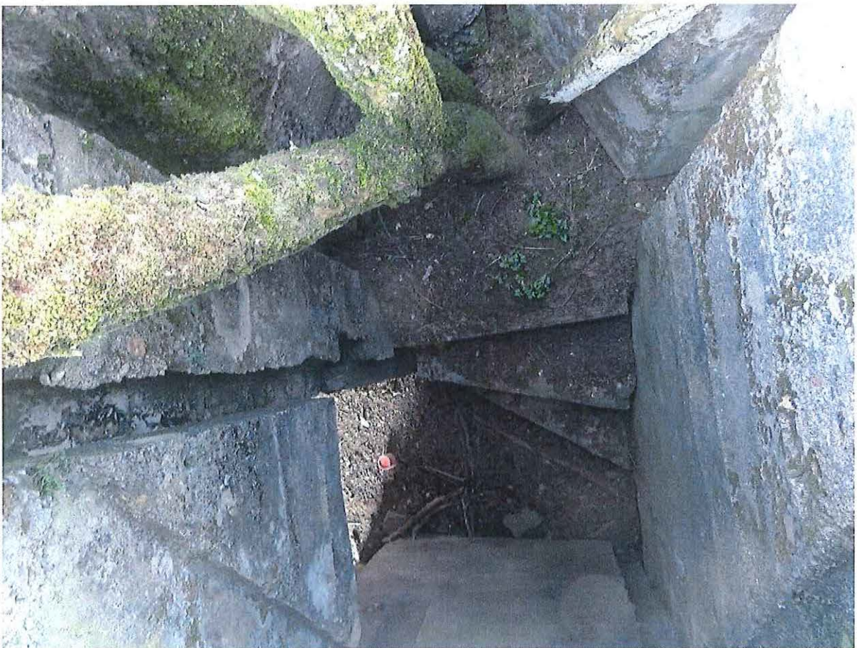
Foto 8: Zicht in het mangat, vanaf het dak.
