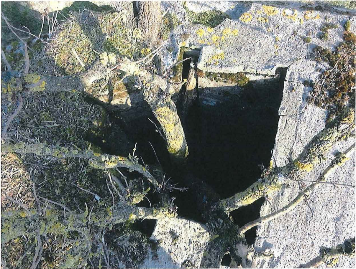
Foto 7: Het mangat, vanaf het dak.
