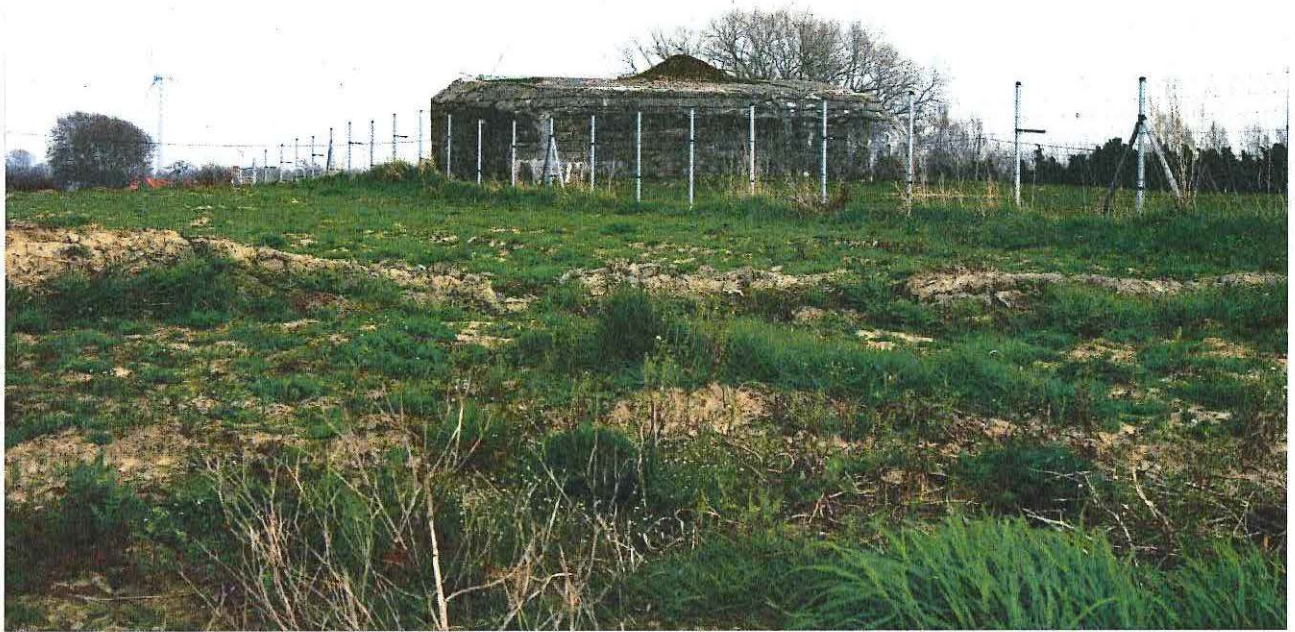
Foto 1: Ligging van de bunker vanaf de Moorseelsesteenweg.
