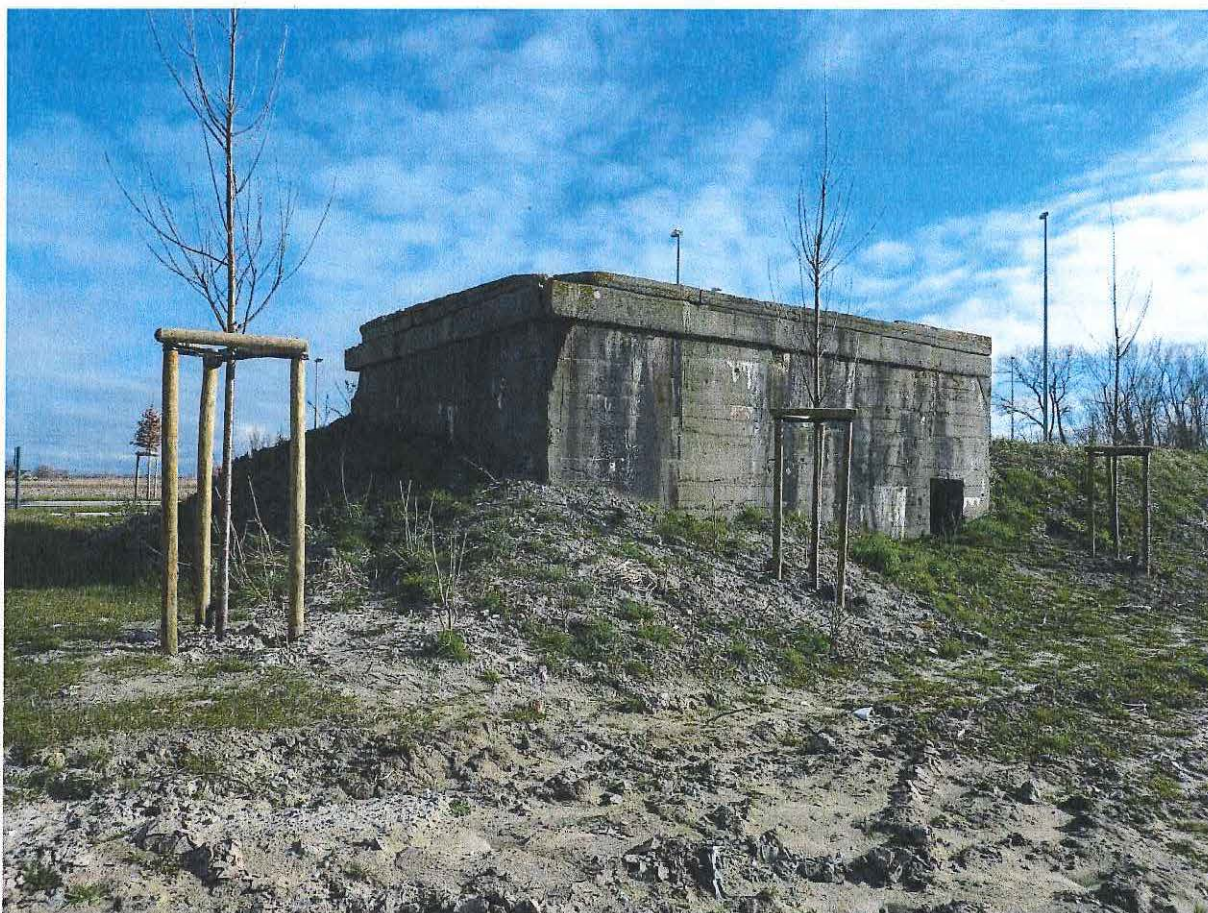
Foto 1: Zicht op de noordwestelijke zijde van de bunker
