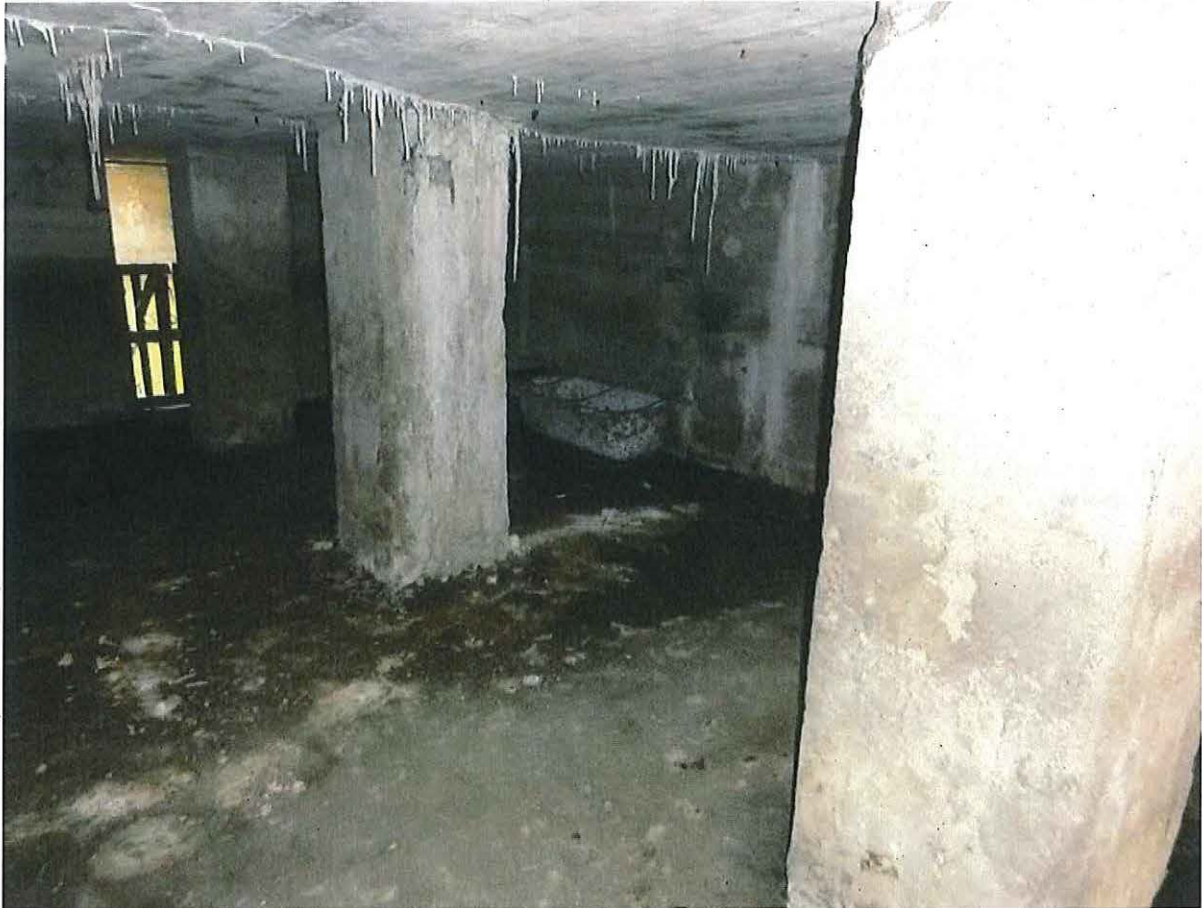
Foto 3: Zicht in de bunker
