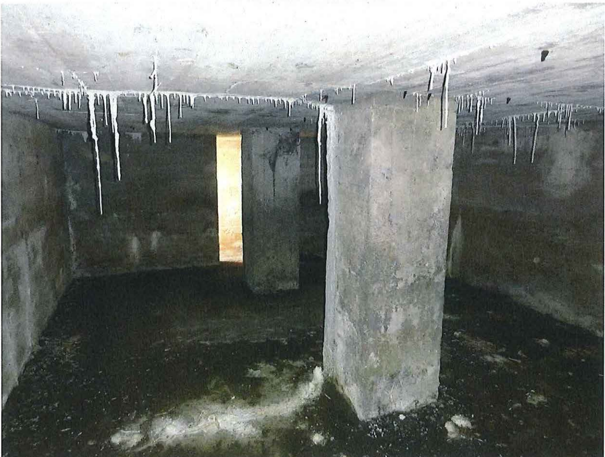
Foto 4: Zicht in de bunker
