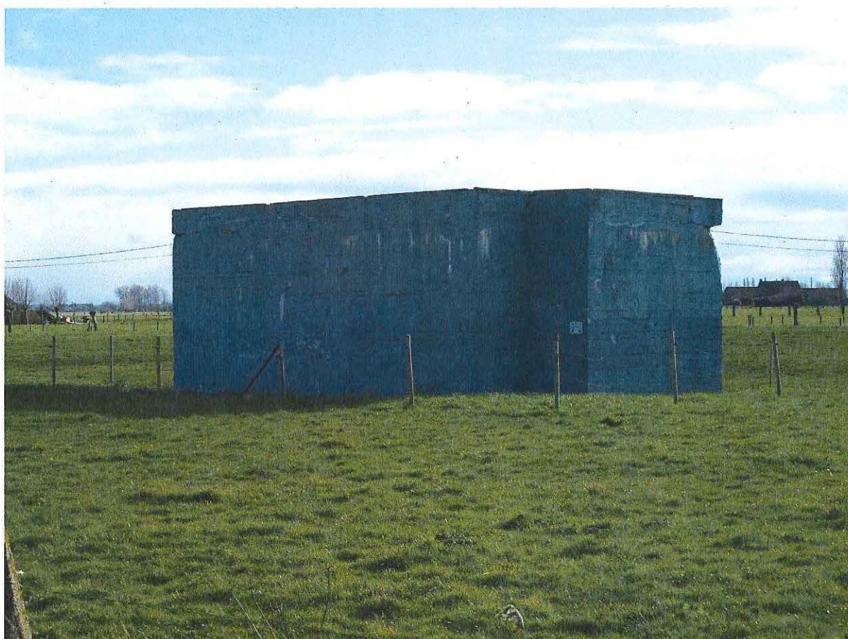
Foto 2: Zicht op de bunker vanuit noordoostelijke richting
