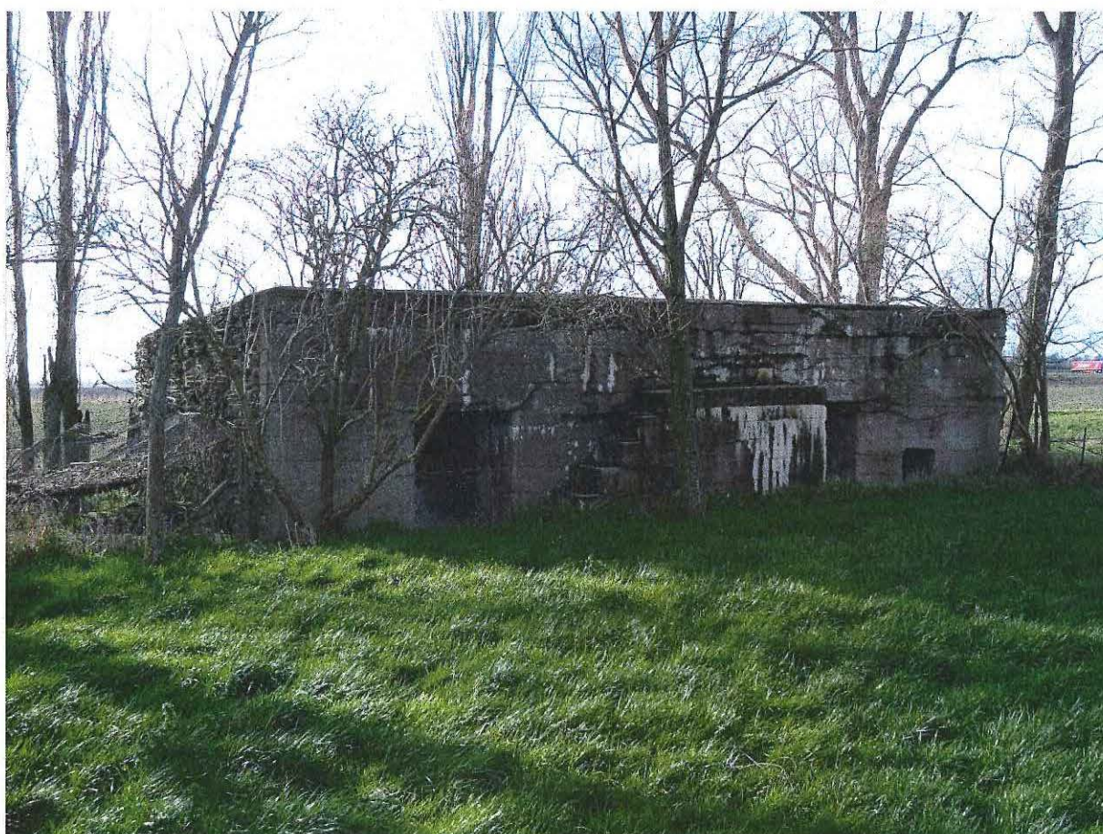
Foto 2: Zicht op de oostelijke zijde van de bunker.
