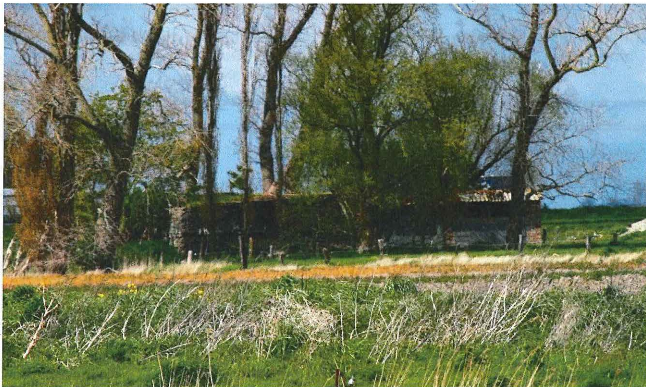
Foto 1: Zicht op de bunker vanaf de Steenstraat.
