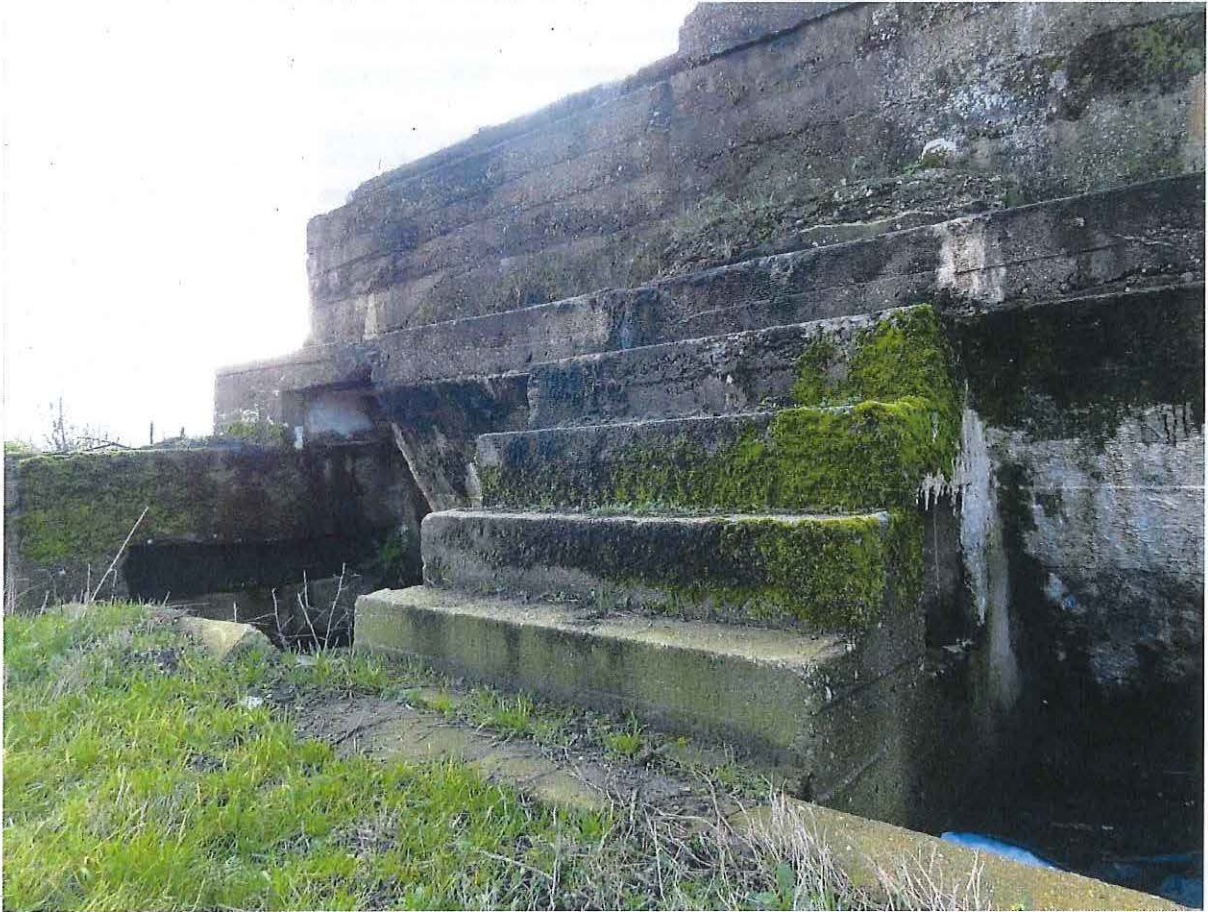
Foto 3: Detail van de oostelijke zijde.
