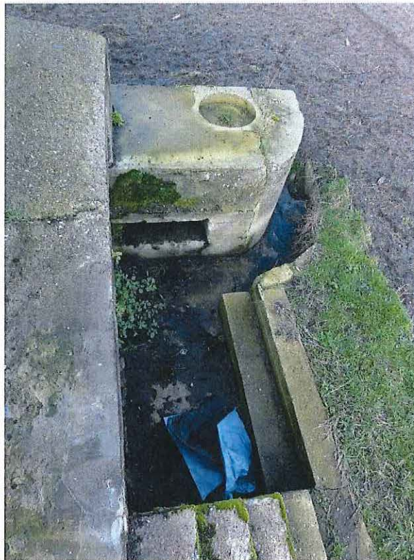
Foto 4: Bovenaanzicht op betonnen platform met borstwering.
