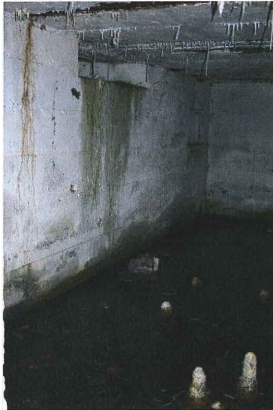
Foto 5: Zicht op een schietopening in de zuidelijke muur.
