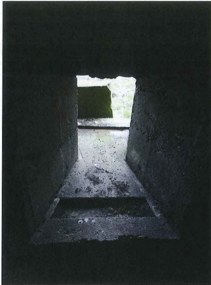
Foto 7: Een opening in de noordelijke zijmuur.
