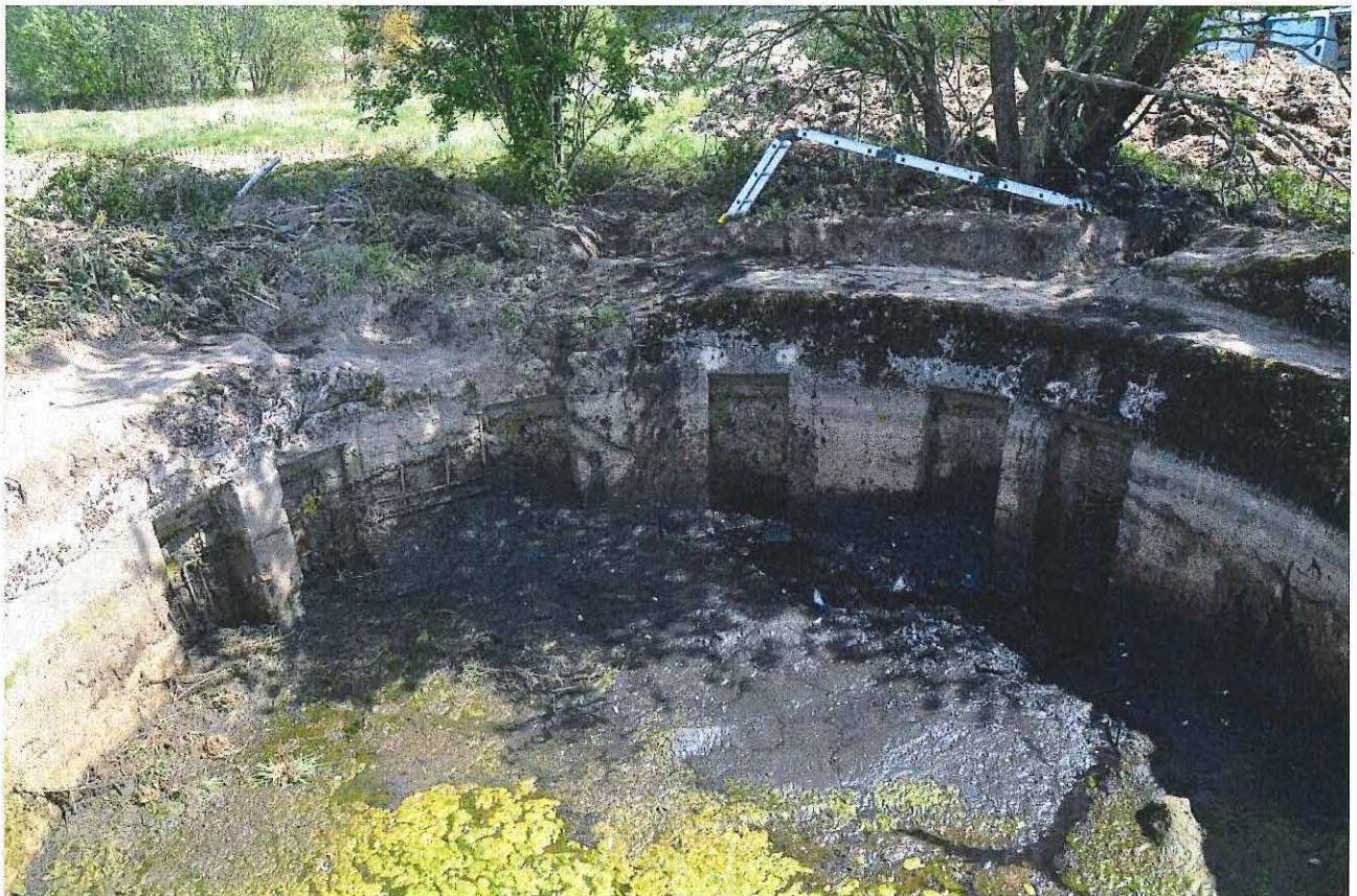
Foto 2: De rechthoekige uitsparingen in de geschutsbedding.
