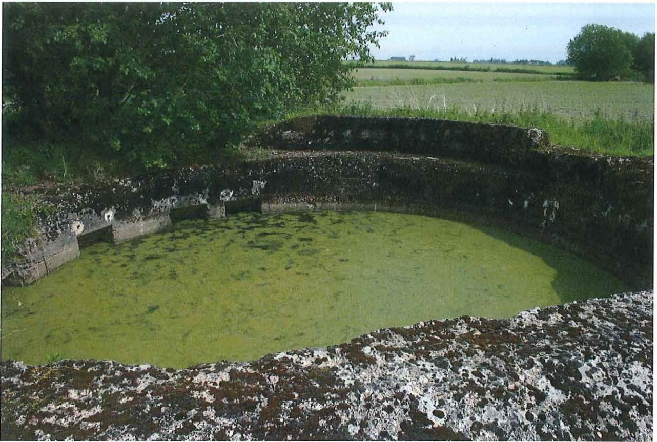
Foto 3: De met water gevulde betonnen geschutsbedding.
