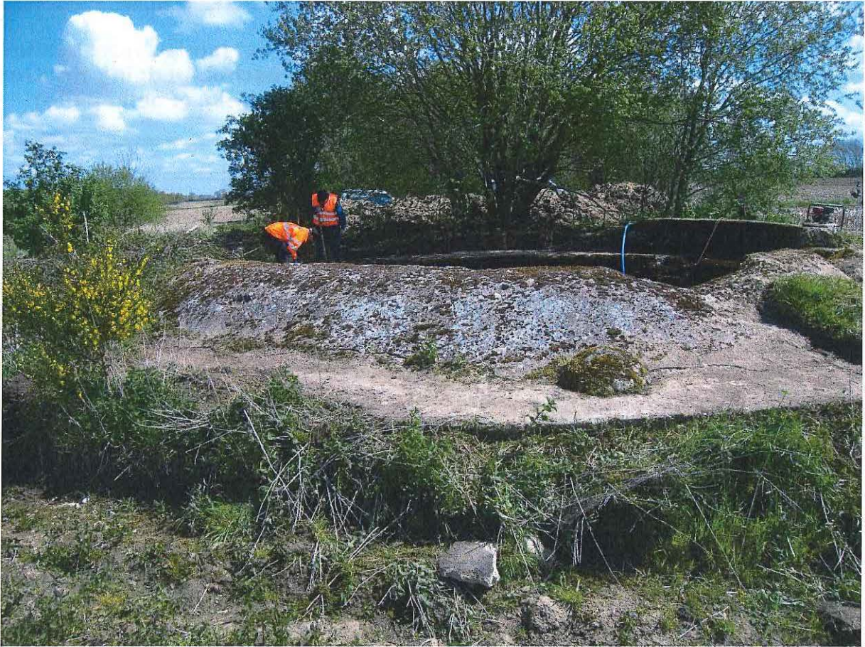
Foto 1: De betonnen geschutsbedding.
