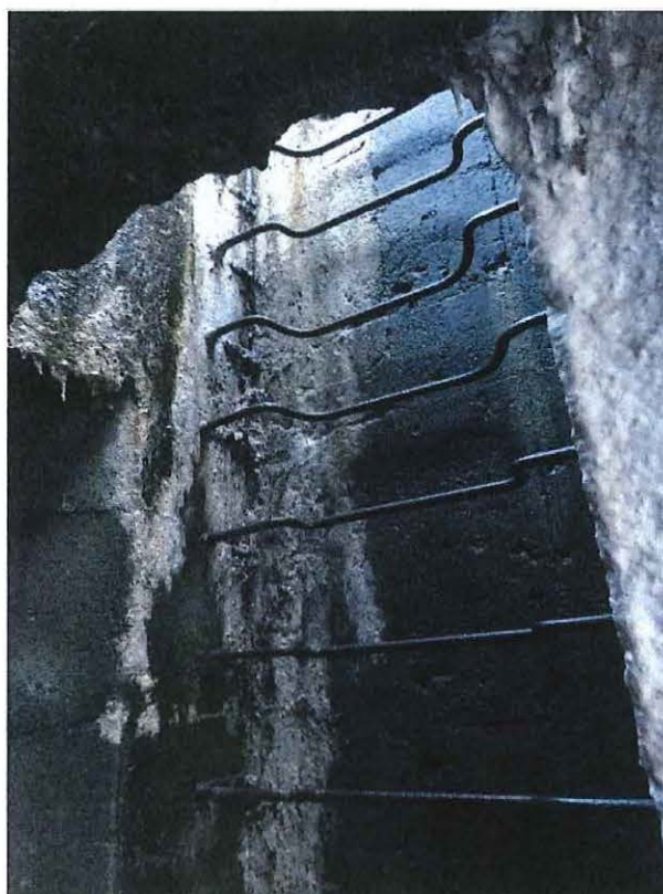
Foto 8: Het mangat met klimijzers.
