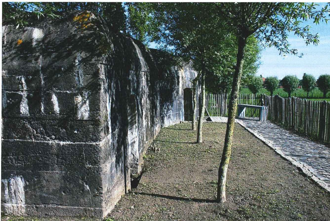
Foto 1: De toegangszijde tot de bunker.
