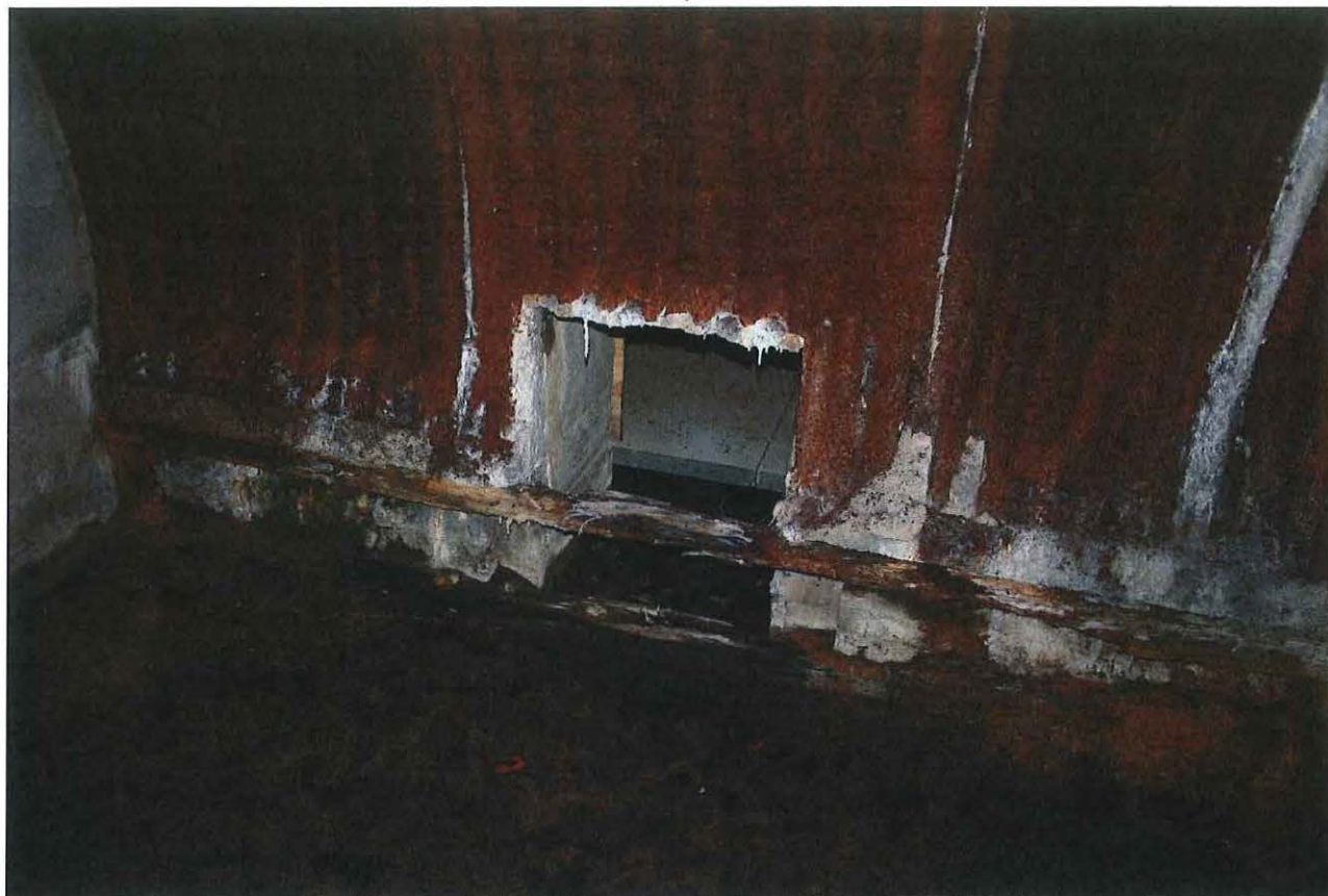
Foto 7: Een lage opening tussen twee ruimtes.
