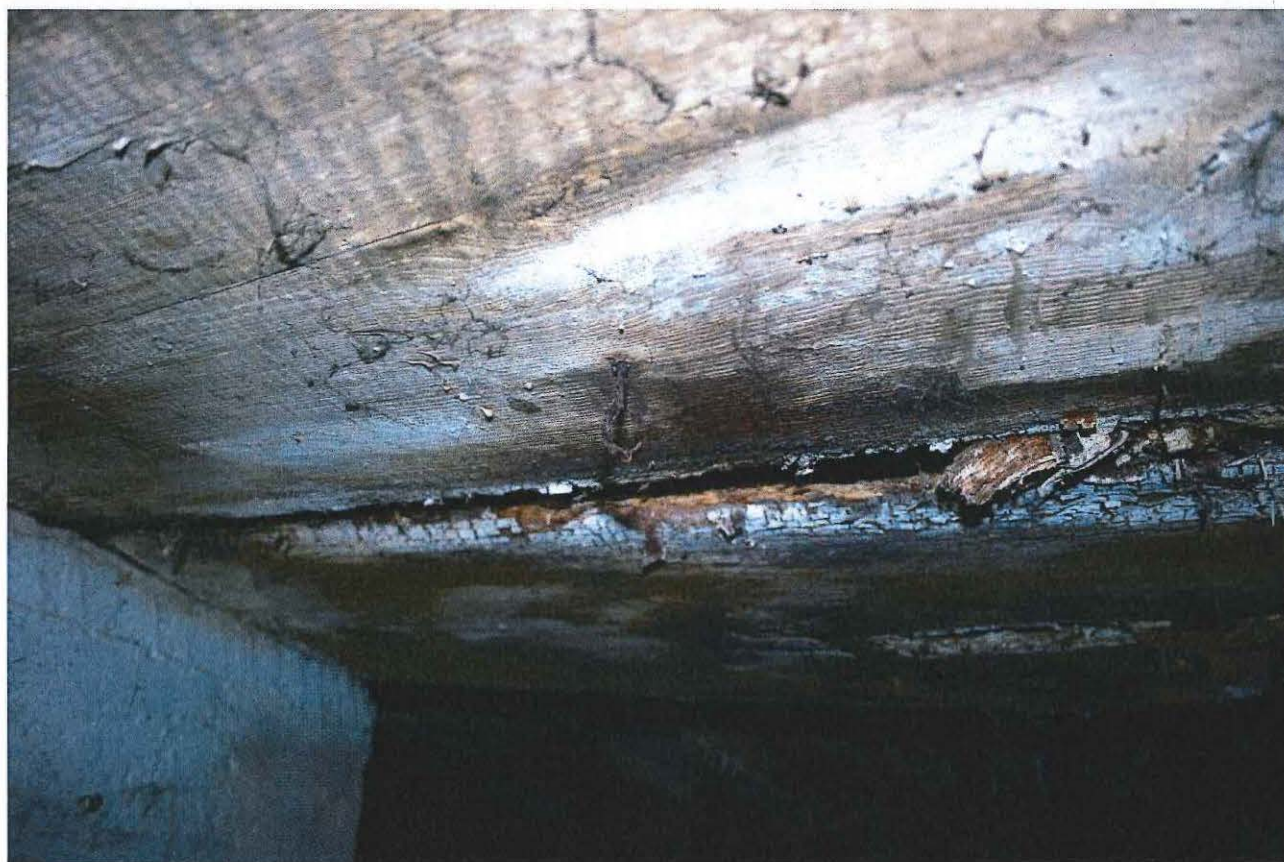
Foto 6: Houten planken met haak boven deuropening.
