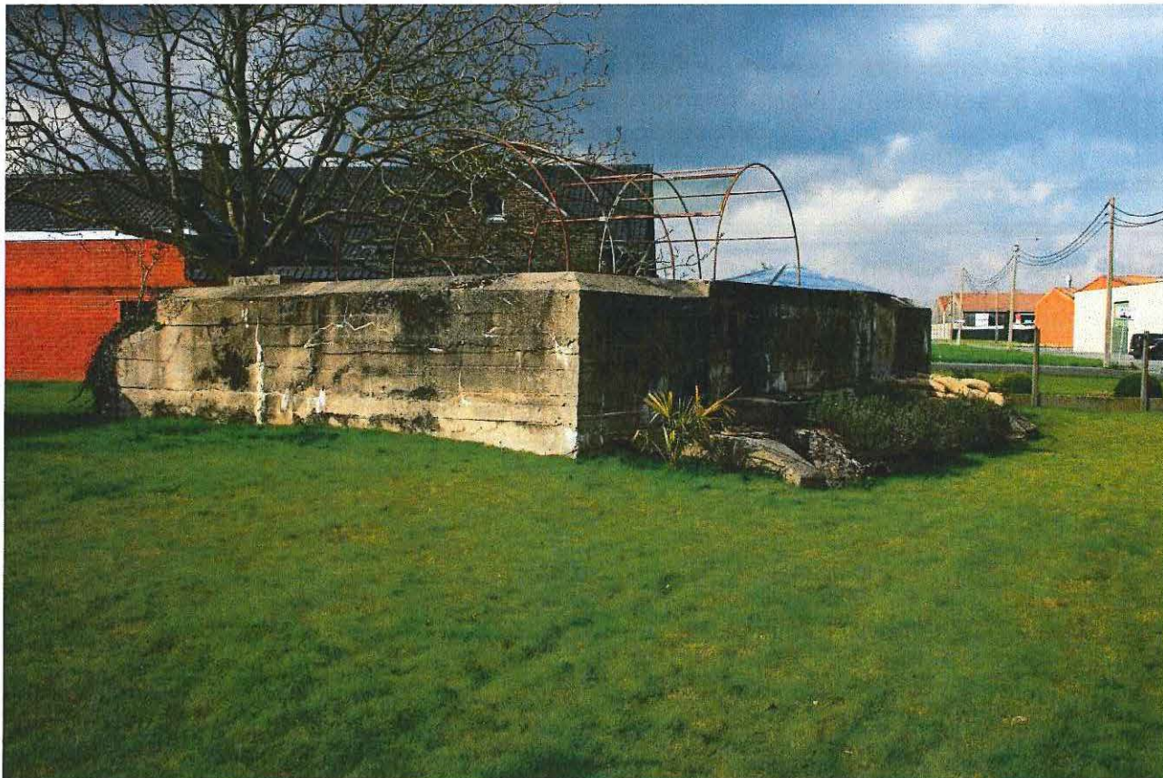
Foto 1: Zicht op de bunker vanaf zuidelijke zijde.
