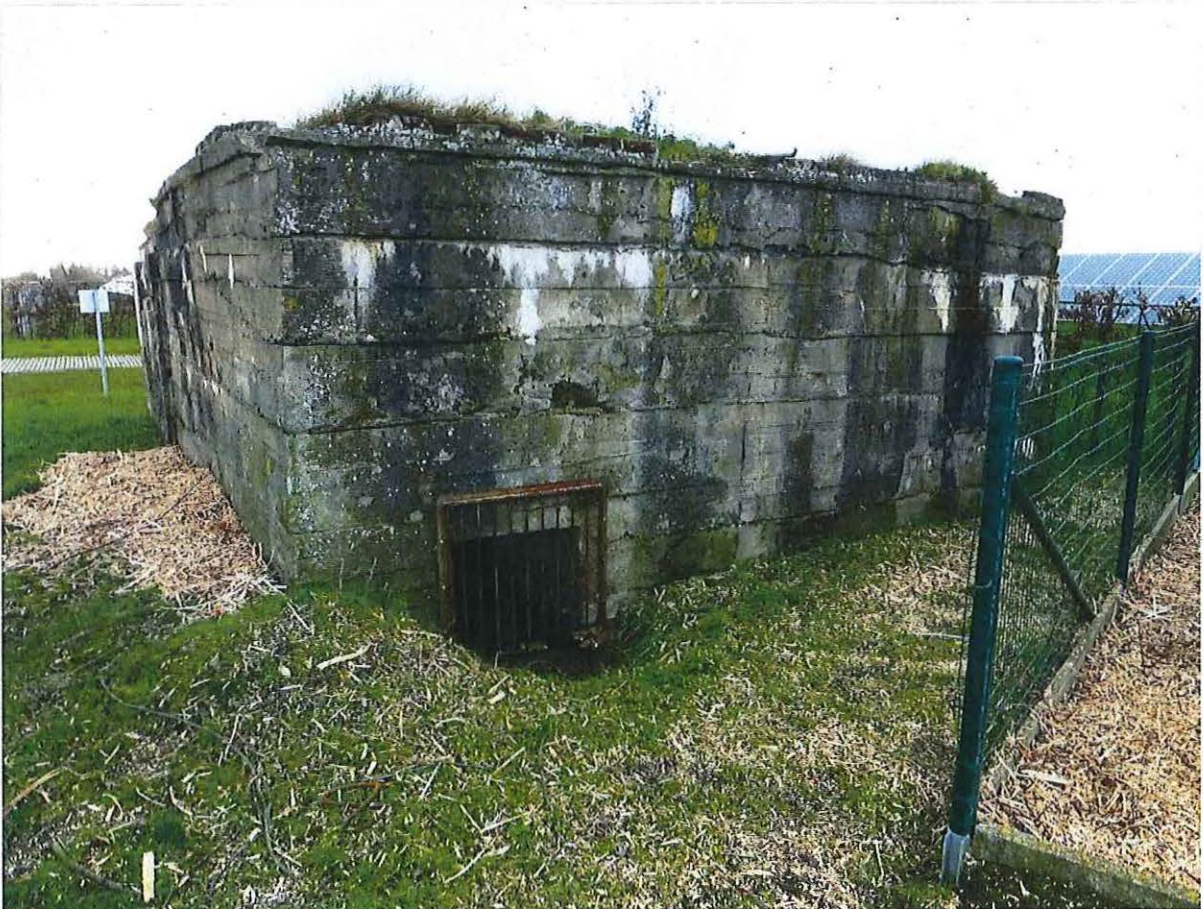
Foto 4: De noordoostelijke zijde van de bunker.
