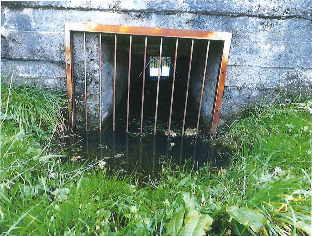
Foto 3: De toegang aan zuidwestelijke zijde.
