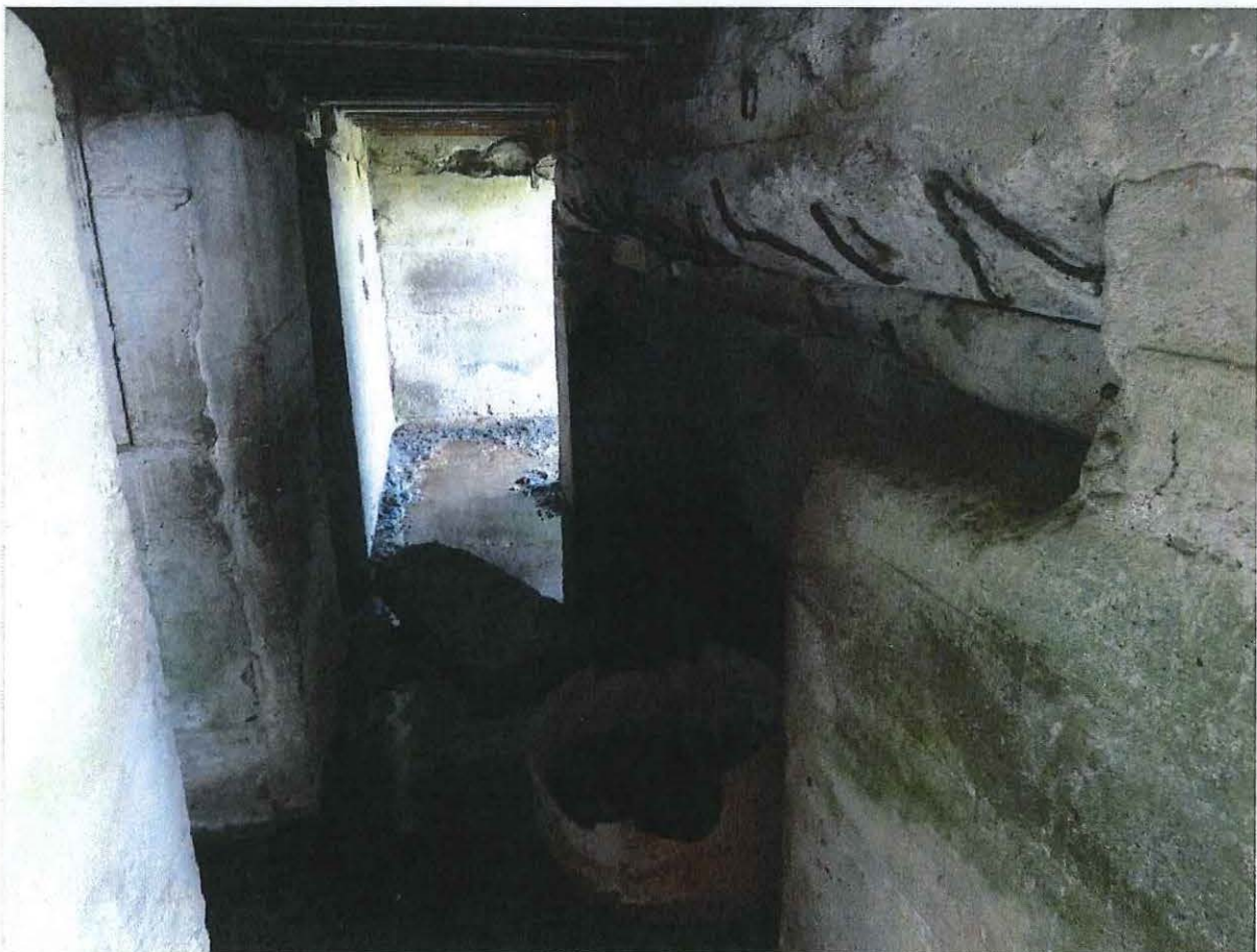
Foto 4: De gang van de bunker.
