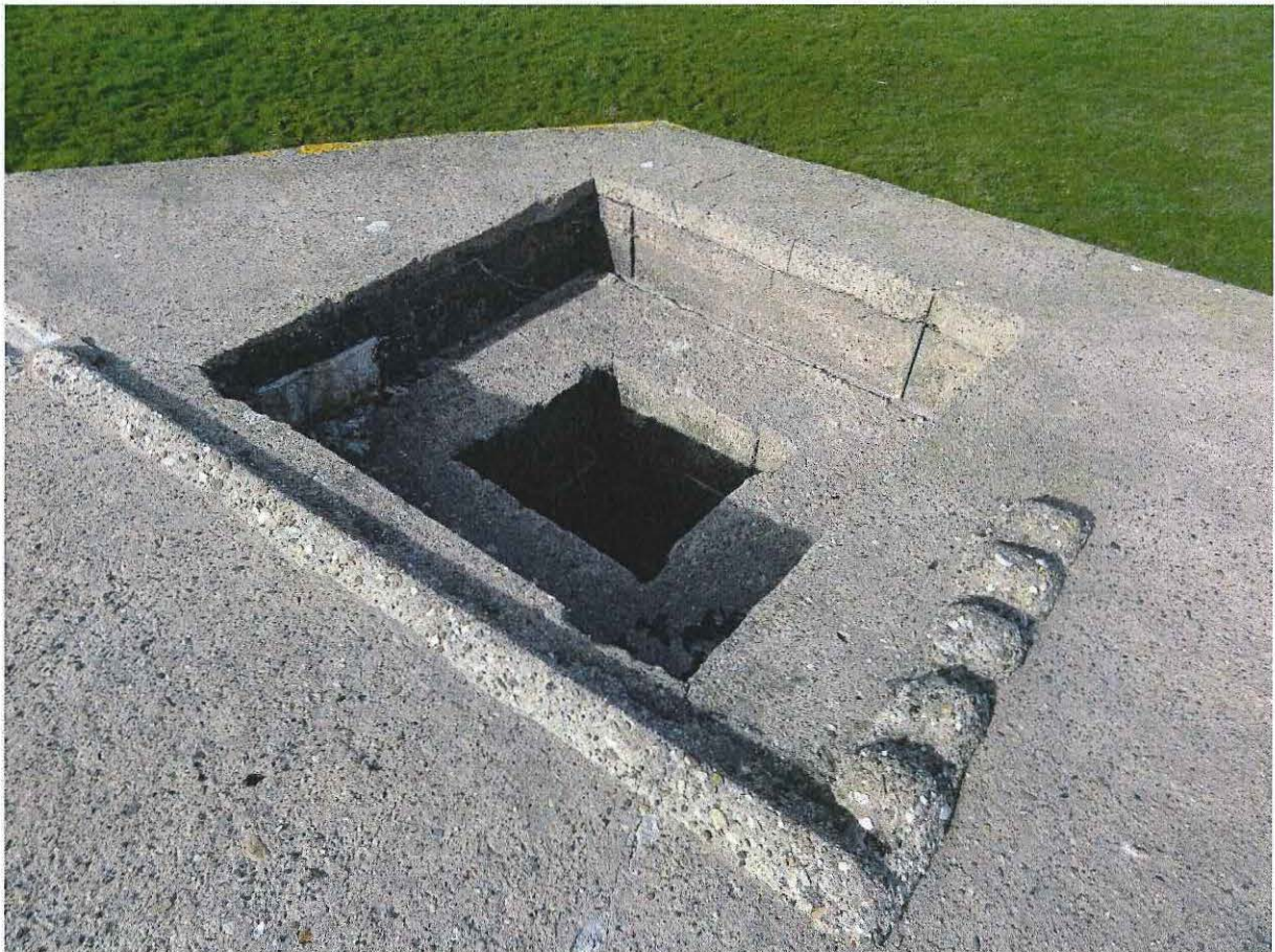
Foto 6: Het mangat met betonnen omranding.
