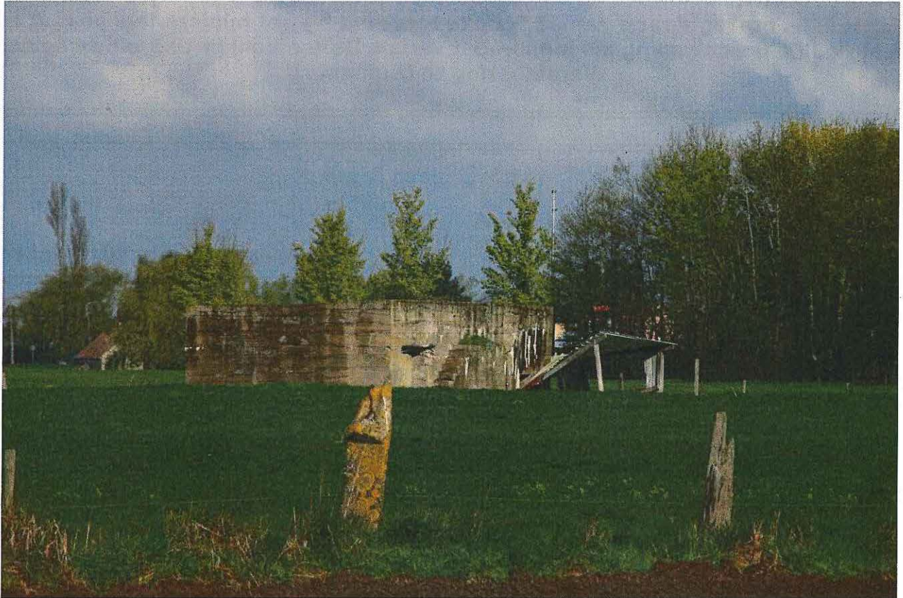
Foto 1: Ligging van de bunker.
