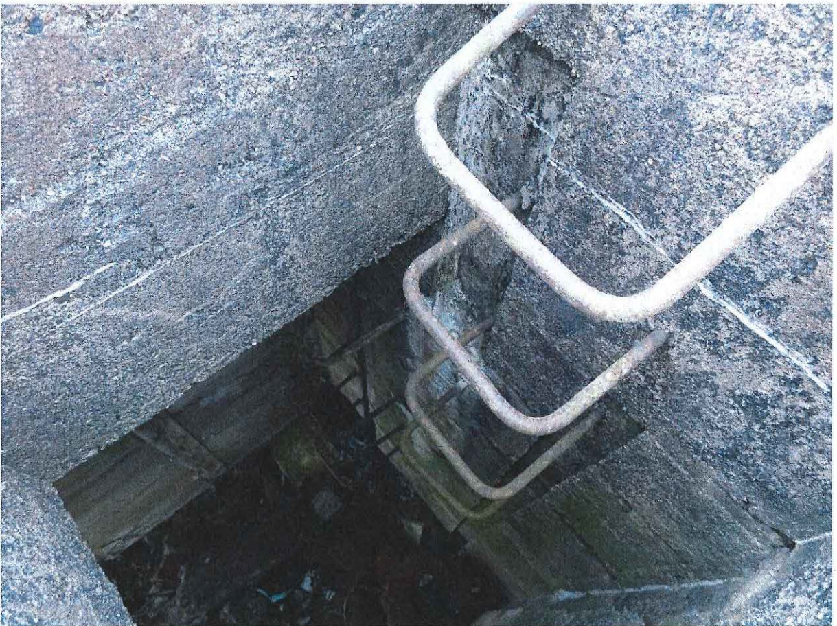
Foto 6: De bewaarde klimijzers in het mangat.
