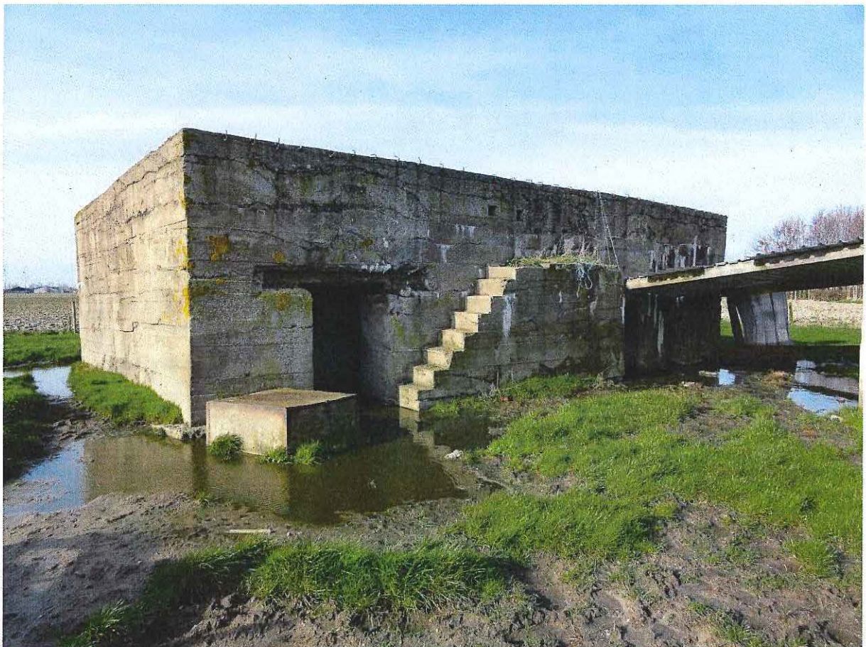
Foto 2: De toegangszijde (noordoostelijke zijde) van de bunker.
