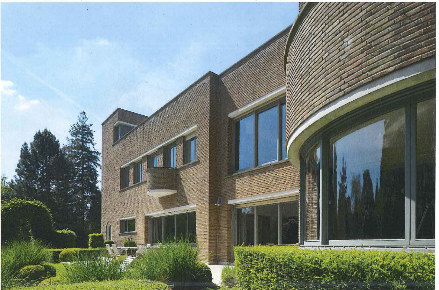
6. Detail van de achtergevel
