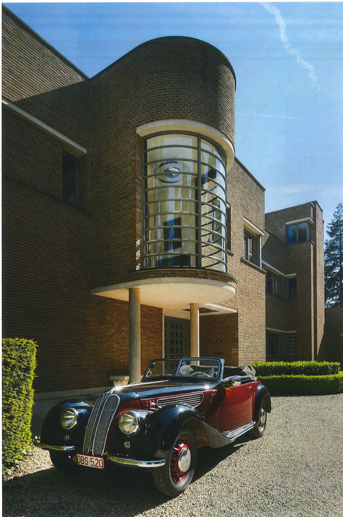
7. Detail van de voorgevel met de erker
